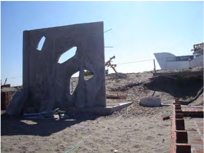
Fig.195 Vista del sitio donde se plantea la construcción del patio de las aguas. La demora ocurrirá en torno al muro West. Fig.196 El patio de las aguas desde la calzada N°2. El sitio todavía aparece como un pasillo Fig.197 El muro west necesita de un zócalo que de sentido a su verticalidad.
