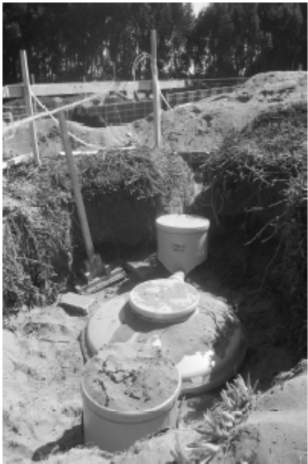
Fig 111 Planilla excel de los recursos ocupados en la ejecución de la red de descarga sanitaria. Fig 112. La instalación de la fosa nº 1 quedó sin problemas bajo el nivel de suelo, puesto que el suelo en este lugar está más alto y, por ende, más lejos de la napa. Fig 113. Para la re-instalación del dren de las celdas se necesitó hacer un profundo herido en la duna dada la altura a la que está el nivel de suelo en este lugar.
