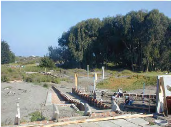
Fig.256 Bloque cemento prefabricado liso gris 9X19X39 cms Fig.257a,b Faena de trazado y confección del herido para ejecutar posteriormente el emplantillado y el perímetro confinador del suelo de la demora. Esta confinación sera hecho a a partir de bloques prefabricados de hormigón. Fig.258 Vista hacia el sur desde la terraza de las celdas. A la izquierda aparece el muro West y el suelo de la demora en construcción.
