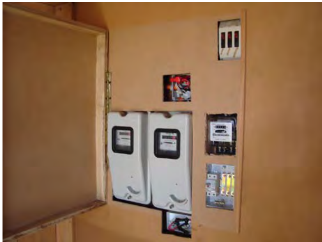
Fig. 96 Comienzo excavación de la red de abastecimiento eléctrico. El punto de origen se encuentra en la sala de música. Fig. 97. Desarrollo de la excavación desde la sala de música. Se sigue recto hasta llegar al sendero peatonal. Fig. 98. Detalle del tablero instalado. A la derecha, al centro se encuentra el remarcador. Bajo este se encuentra el interruptor automático y diferencial. medio Fig. 99 Desarrollo de la excavación de la red eléctrica mirada desde la sala de música en dirección a la vega.
