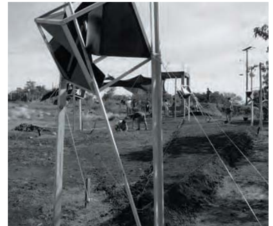
Faenas de la obra.
