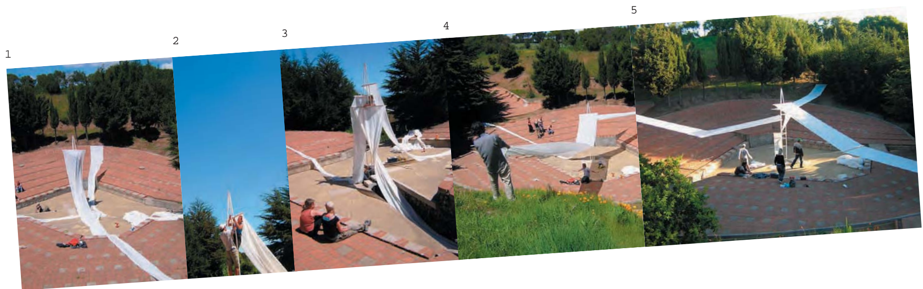
1- Presentación de las telas./ 2,3- Amarre de las telas al pilar central./ 4- Amarre de las telas en los centros al piso y en los extremos a los arboles y estacas en los bordes del anfiteatro./ 5- Trabajo finalizado.
