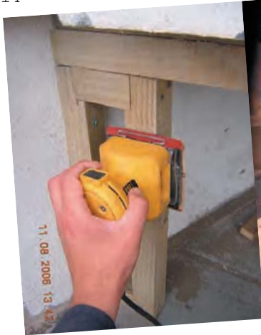
14- Lijado de los marcos./ 15- Puertas de terciado estructural, se refuerzan en los extremos donde va la union con los marcos./ 16,17- Tarugos encolados para la postura de los tornillos de las bisagras./ 18- Bisagras.
