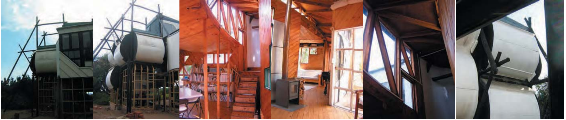
Exterior Alcoba, progresion vertical. / Interior, "puro interior". / Detalles de la hospederia.
