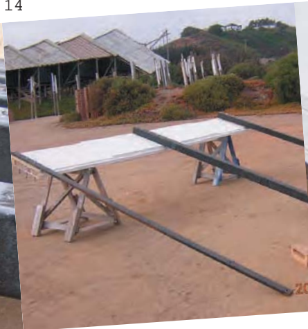
13- Se perforan los fierros./ 14- Viga+pilares = panel estructural./ 15- Detalle de union entre pilar y viga./ 16- Detalle de union entre pilares y vigas inferiores.
