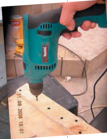
14- Lijado de los marcos./ 15- Puertas de terciado estructural, se refuerzan en los extremos donde va la union con los marcos./ 16,17- Tarugos encolados para la postura de los tornillos de las bisagras./ 18- Bisagras.
