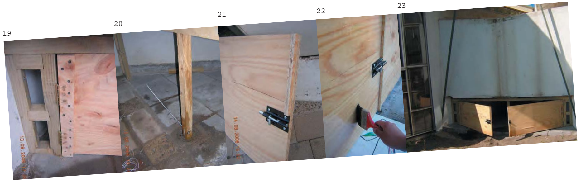
19- Colocacion de las puertas./ 20- Marco central unido a la pieza inferior con hilo de 10./ 21- Cerradura./ 22- barnizado de puertas./ 23- Bodegas finalizadas.
