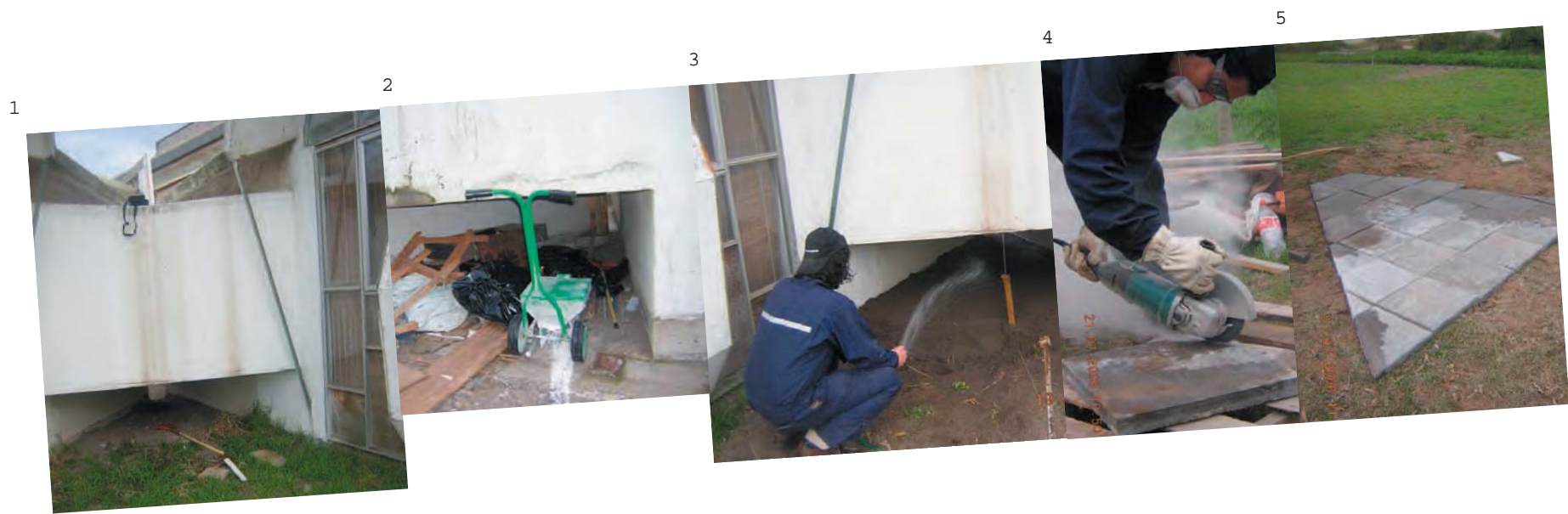
1,2- Estado inicial./ 3- limpieza, compactacion y nivelacion del suelo./ 4,5- Dimensionado de las locetas de hormigon que iran en el piso.
