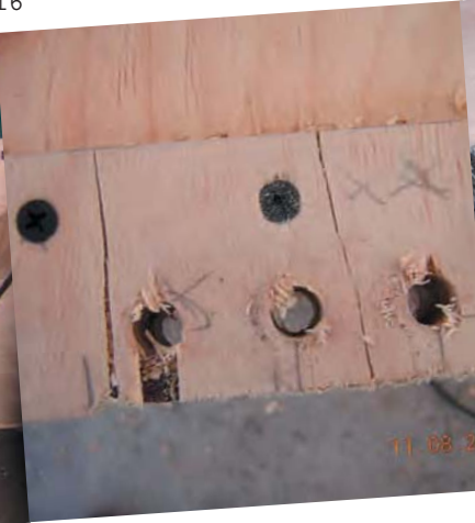
14- Lijado de los marcos./ 15- Puertas de terciado estructural, se refuerzan en los extremos donde va la union con los marcos./ 16,17- Tarugos encolados para la postura de los tornillos de las bisagras./ 18- Bisagras.
