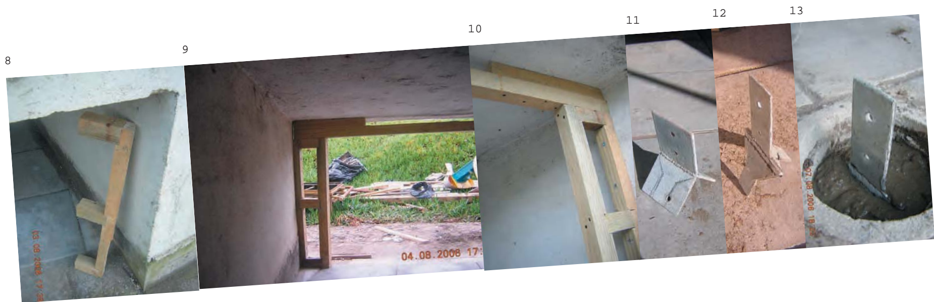
8- Marcos laterales./ 9- Marcos lateral y superior./ 10- Fijaciones al muro mediante clavos de expansion./ 11- Pieza que une al marco central con el suelo./ 12- Se corta el extremo inferior con esmeril, para que quepa en el agujero del suelo./ 13- Se fija al suelo con hormigon.
