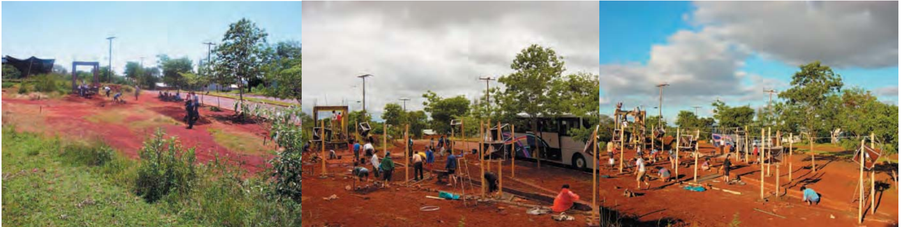
Progreso de la obra.
