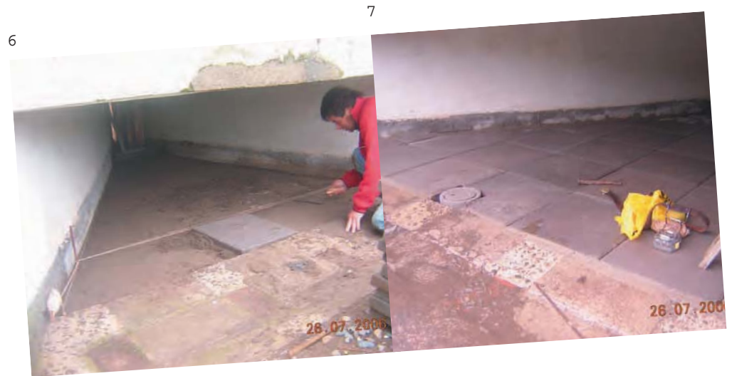
6- Postura de locetas, el suelo se nivela con lienza./ 7- suelo terminado
