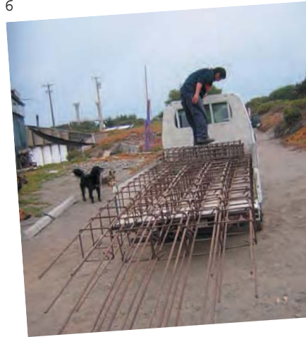
6-se trasladan los fierros desde el taller del trabajo hasta el lugar de las faenas./ 7- Presentación de los "encepados" en su lugar definitivo.
