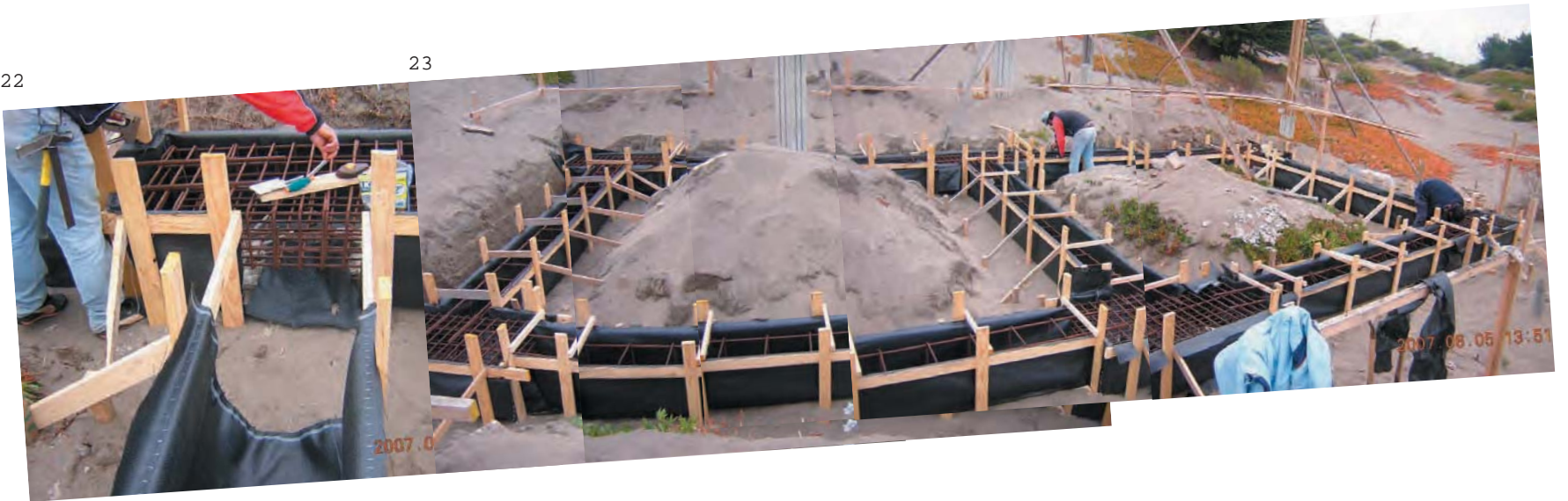
22- Detalle de union entre encepados y vigas./ 23- panoramica de la obra.
