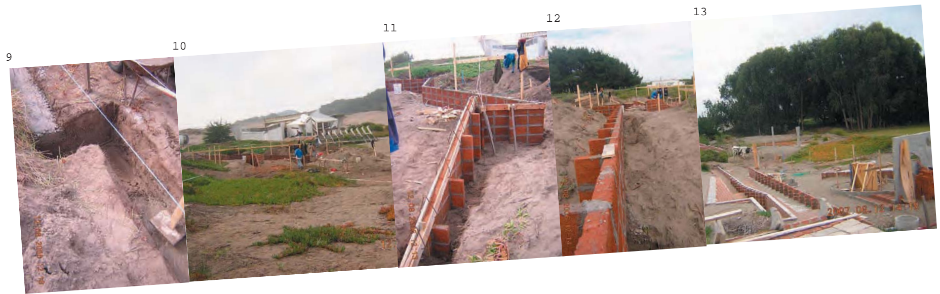
9 Emplantillado y compactacion. / 10 Vista parcial. / 11-12 Detalle albañileria. / 13 Sitio de las calzadas.
