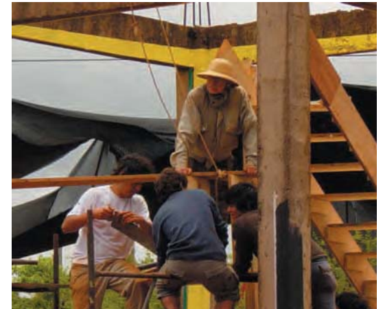
Ejecucion de la escalera iterior del cubo de hormigon.
