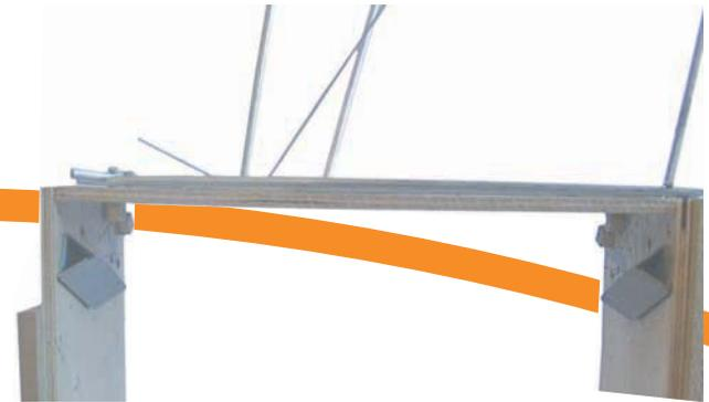
[ Detalle piezas de encaje de bandeja en el interior del núcleo ]
