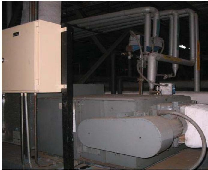
Figura 2-3. Unidad manejadora de aire G 21-27.
