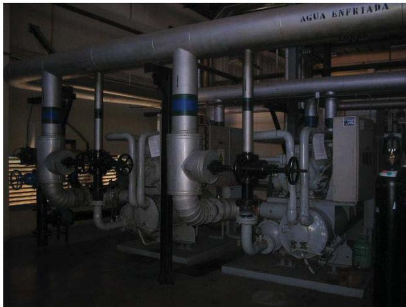
Figura 1-5. Sistema de refrigeración.
