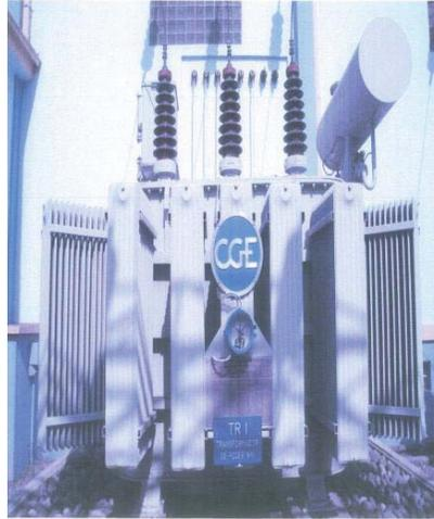
Figura 2-6: Transformador de Poder. (Imagen Propia).
