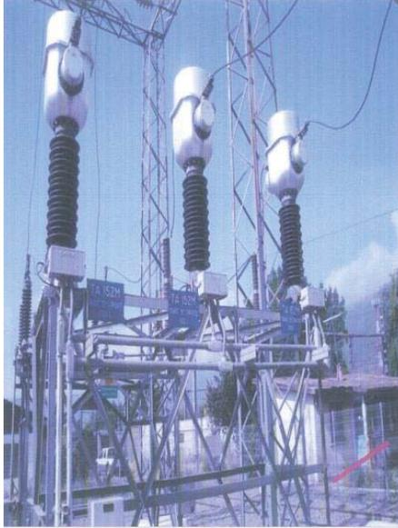
Figura 2-8: Transformadores de Corriente. (Imagen Propia).
