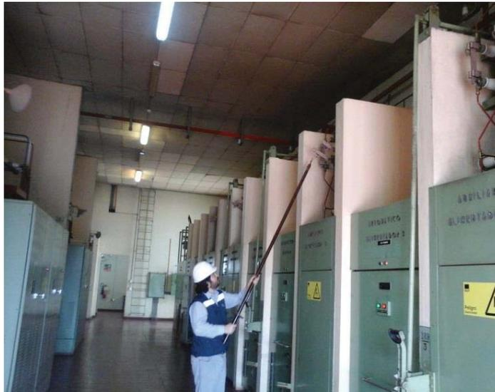
Figura 2-2: Operador de Subestaciones Ejecutando Maniobras. (Imagen Propia).
