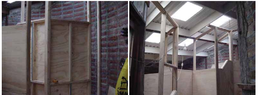
Detalle de la construcción de los tabiques y del horizonte de transparencias
