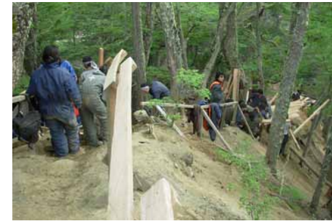
escalera acceso parque
