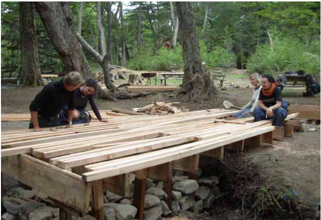
Se utilizan piedras para estabilizar el suelo junto al río.
