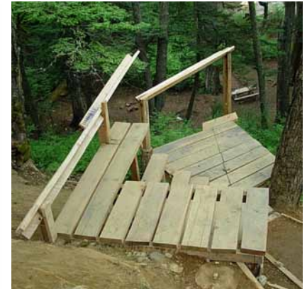
3.- unir costaneras, y estructura del piso
