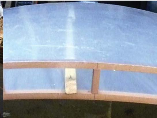
La cubierta se tensa y con la viga se forma la doble cámara.
