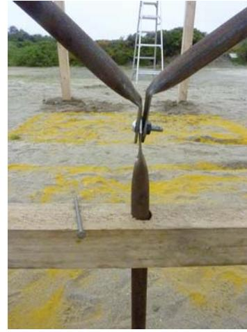
LA UNION DE LA PIEZA DEBE SER CON UN PIVOTE YA QUE AL LEVANTARSE LA CUBIERTA LA PIEZA DEBE TENER UN MOVIMIENTO RECTO QUE SE LOGRA CON EL PIVOTE YA QUE SINO LA PIEZA SE INCLINARÍA HACIA EL INTERIOR.
