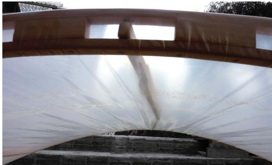
La dobel camara genera un viga resistente y con mayor aislación térmica.
