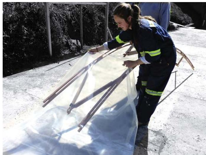
Para que el poleitileno entre en la manga y no produzca daños en el plastico se requiere la ayuda de 2 personas, una sosteniendo y levantando la viga y la otra insertando el plástico.
