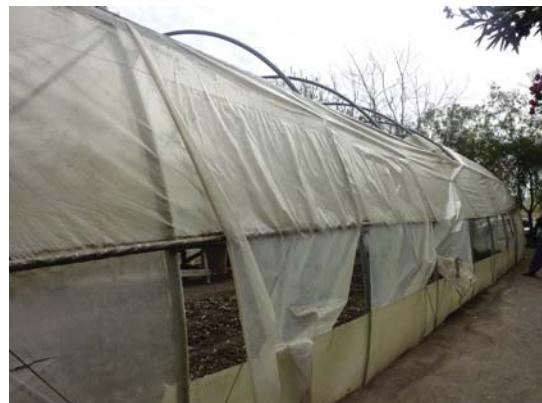
La forma de ventilación es a través de ventanas de polietileno que se enrollan.
