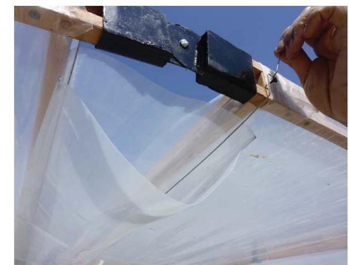
se termina el atornillado de la canaleta por el otro lado.
