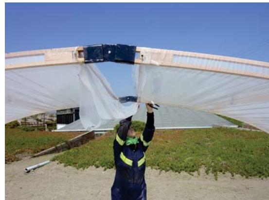
LA CANALETA SE INSTALA CON LOS ALAMBRES EN UN LADO Y LUEGO EN OTRO.CUANDO LAS CUBIERTAS ESTAN VINCULADAS
