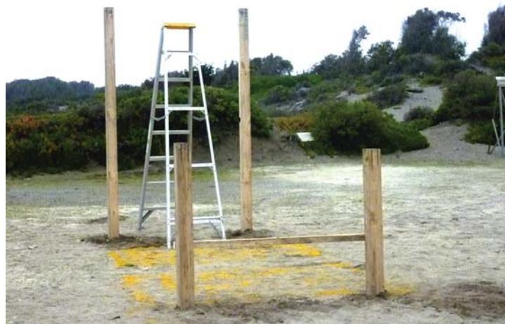
Los cuartones son la base de las cubiertas, ya que las sostienen. Los cuartones ayudan a contener las terrazas a modo de muros de contención. En un cuartón se ensamblan 2 cubiertas.
