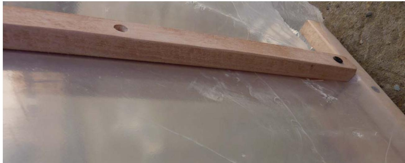
El plastico finalmente queda sellado y tenso alo largo de toda la cubierta, se sella por lo que la madera se protege, exceptuando el liston sellante, que debe ser tratado con un sellante para protegerlo. El liston sellante queda por el interior de la cubierta en su lado cóncavo por lo que la madera no corre riesgos.
