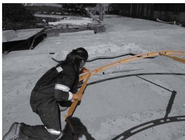
DESPUEDE SE ENSAMBLA UNO DE LOS DOS LADOS, LA VIGA YA SE MANTIENE SOLA LO CUAL NO ES NECESARIO SOSTENERLA.
