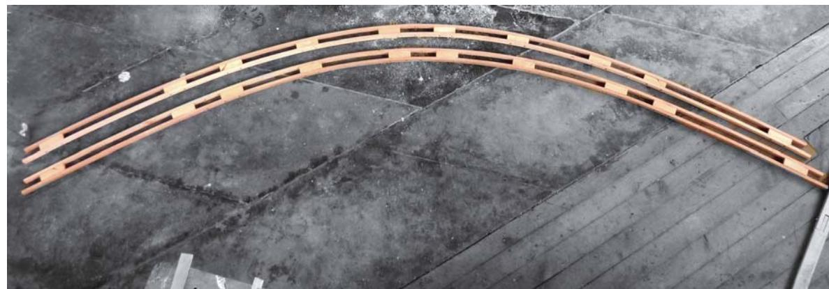
LA CURVA SE MANTIENE POR LA UNION DE LOS DOS ARCOS CON TACONES DE 10 CM. EL ARCO INFERIOR TIENE UNA MENOR MEDIDA QUE EL ARCO SUPERIOR POR LO QUE LO MANTIENE CURVADO.
