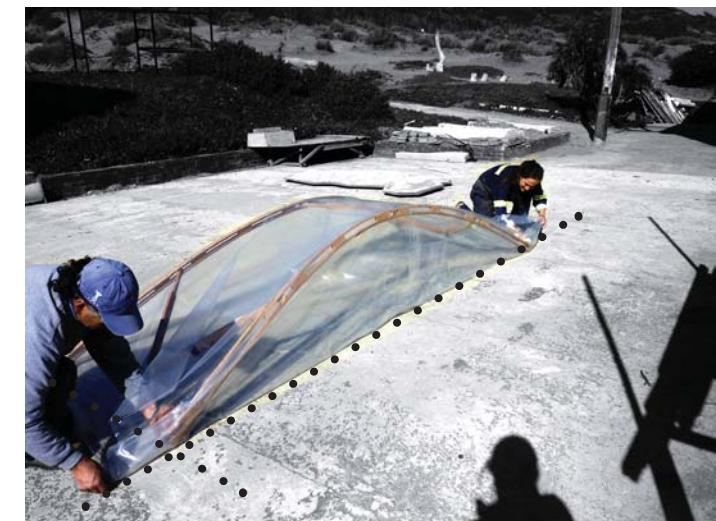
Se debe estirar el plastico que queda arrigado en el centro debe formar una linea recta. con el suelo.Ademas se debe formar un aresta perpendicular.
