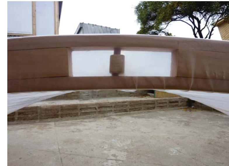
EL ESPESOR DE 3 CM MAS LOS EL ESPESOR DE LOS LISTONES DA UN TOTAL DE 6 CM. LO ADECUADO PARA CREAR LA DOBLE CAMAARA.
