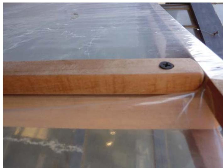
Luego se estira la otra parte de la manga, la parte interior, se tensa con la mano y pasa por sobre el liston fijador, y luego sobre este se calza el liston que sella la viga,.El liston que sella hace presión sobre los dos plasticos manteniéndolos tensos y fijos.
