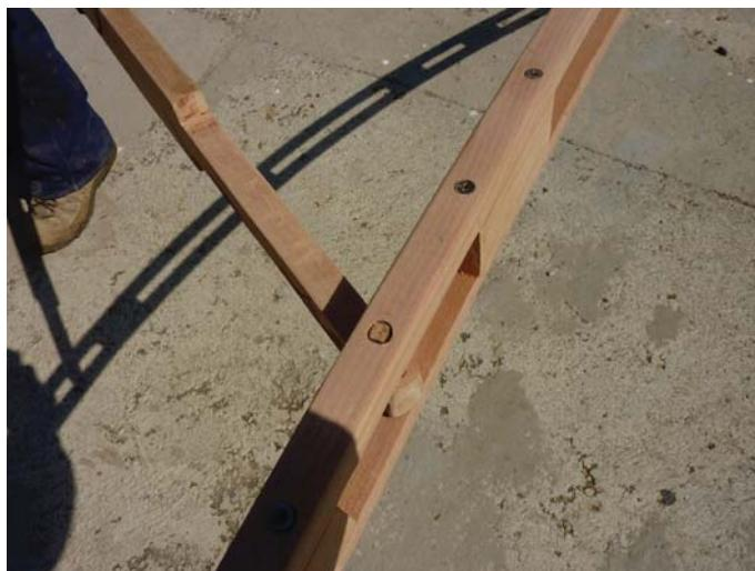
SE OBSERVA EL CORTE Y EL PORQUE DEL CORTE; EL CORTE ES PARA CALZARLO EN EL ESPESOR INTERIOR DE LA VIGA CON UN TARUGO Y PARA QUE LA PIEZA PUEDA GIRAR Y ASÍ REDUCIR EL TAMAÑO DEL ANCHO DE LA CUBIERTA.
