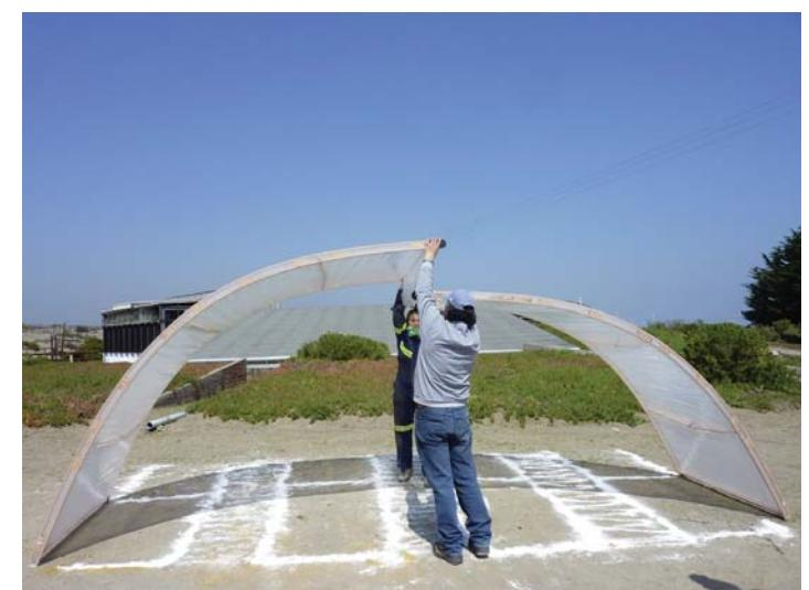
Se juntan y enderezan las dos cubiertas
