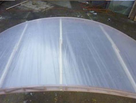
Cubierta tensa en el centro y no en los extremos, los extremos se tensan después.
