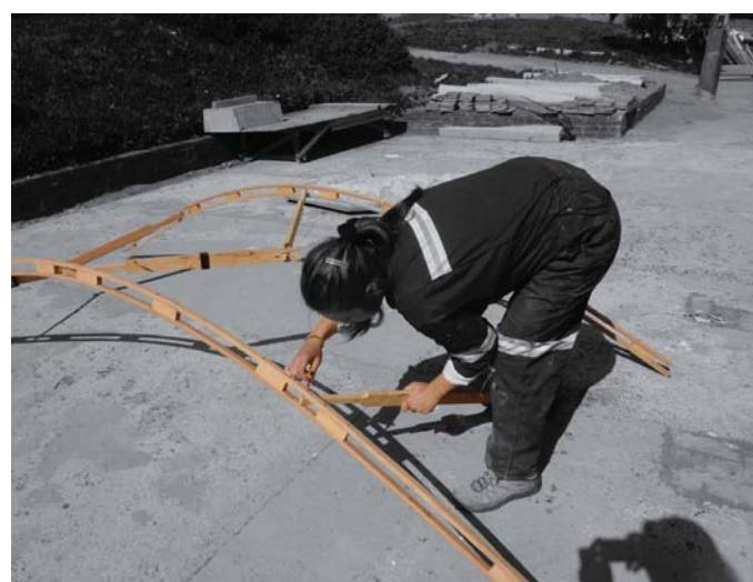
Y FINALMENTE SE ENSAMBLA EL OTRO LADO CON LA ULTIMA PIEZA PIVOTE INTERIOR.
