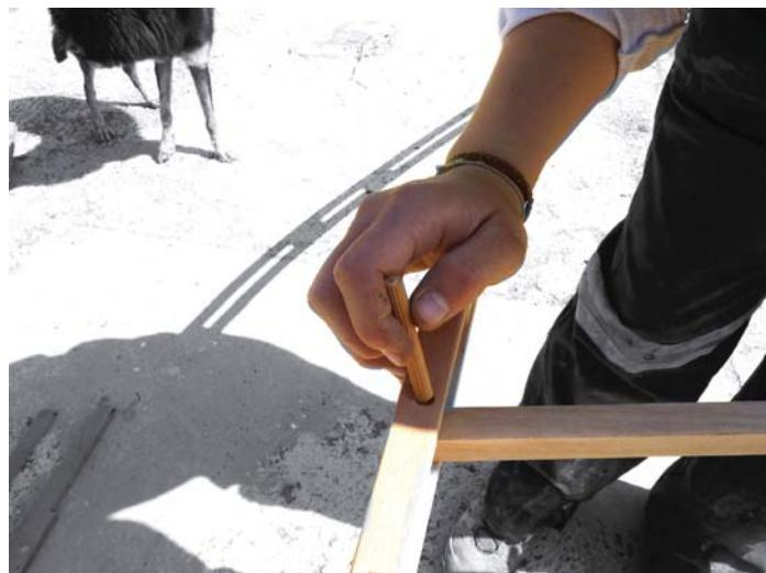
Se ensambla la primera pieza interior en el centro de los arcos centrales., se ensambla con un tarugo en el orificio del centro del arco, primero un lado y luego el otro.
