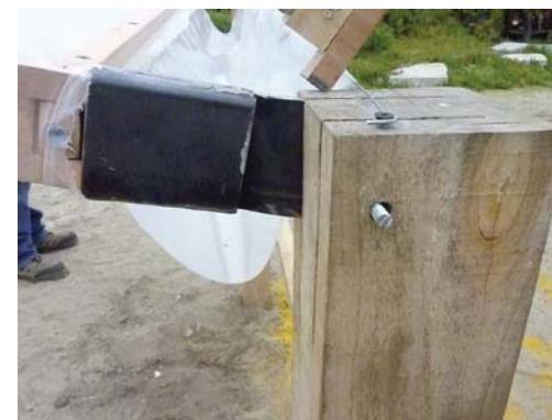
EL PIVOTE SE GENERA CON UN PERNO EL CUAL ATRAVIESA EL CUARTON Y LA PIEZA DE FIERRO INTERIOR.
