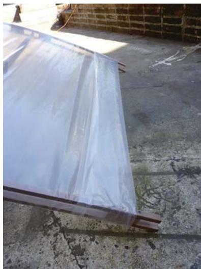
Cuando la viga esta armada y extendida dentro de la manga de polietileno se fijan listones en los extremos de la cubierta para terminar el tensado del plástico
