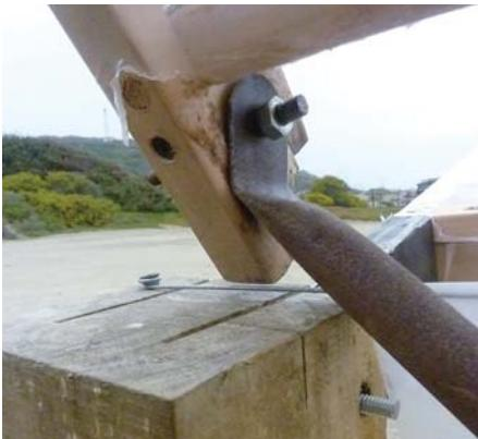
Se ensambla ala cubierta con un perno
