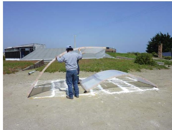
Se levanta una cubierta y luego la siguiente. El ancho del suelo debe ser de 5 metros.
