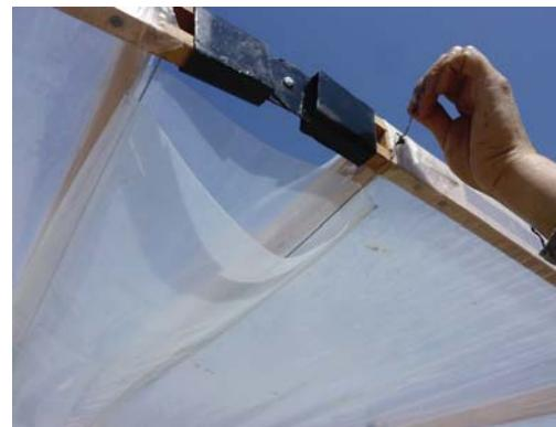
La canaleta se instala en la cubierta. con los alambres de los costados Los alambres se sujetan a los tornillos que son puestos en el liston fijador.
