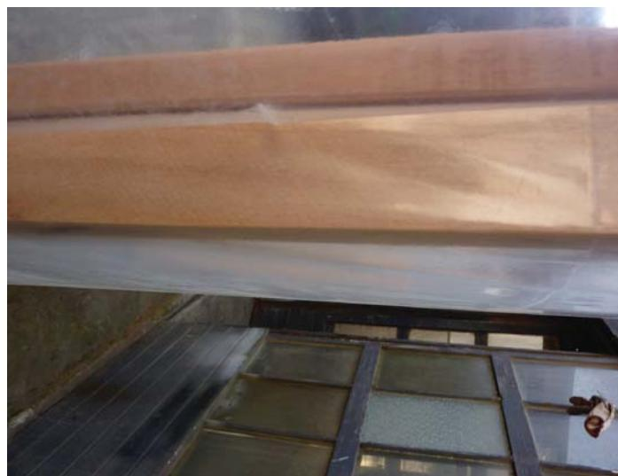
La madera que queda afuera se protege con polietileno, y el liston sellante queda para adentro hacia la parte cóncava por lo que no es afectado directamente.
