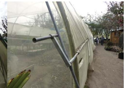
la forma de ventilación es através de una manilla que enrolla el polietileno.
