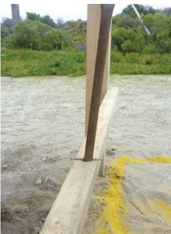
LA PIEZA DE FIERRO SE CALZA EN EL PALO CON UN ORIFICIO DONDE SE CALZA EL TUBO DE FIERRO LA ABERTURA ES REGULADA POR UN CLAVO QUE CRUZA EL TUBO Y SE PUEDE REGULAR LA DISTANCIA Y POR LO TANTO LA ABERTURA.
