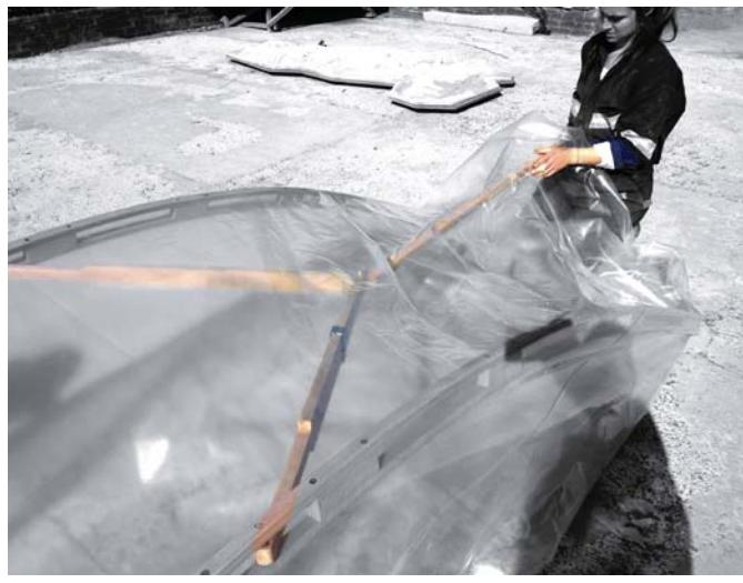
Con el listón de fuerza (herramienta que se usa para poder mover las piezas de pivote interiores, es una extensión del braxo, se utiliza para alcanzar a empujar las piezas.), se empuja hacia adelante hasta enderezar la pieza pivotante.
