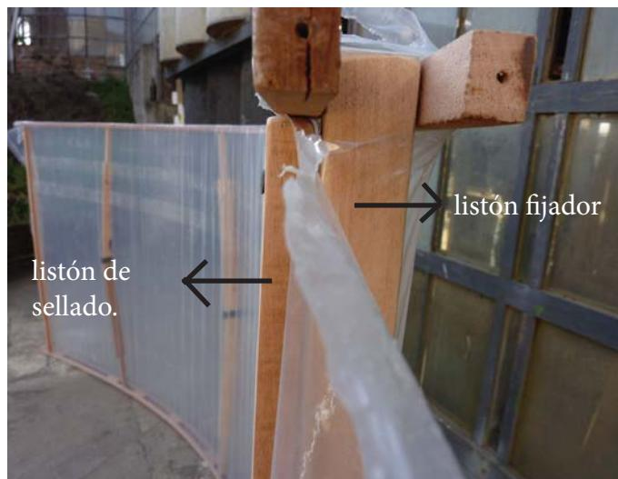
Se observa el liston fijador y liston de sellado, el liston se calza y se atornilla sobre el liston fijo. Así se mantiene el plástico fijo y tenso en la parte final.
