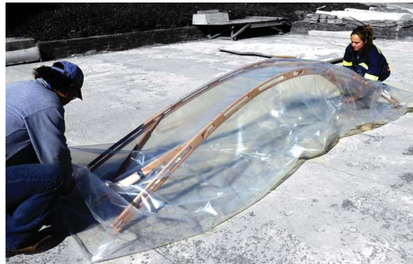
Cuando la viga esta completamente dentro de la manga,, se empieza a enderezar la estructura para que quede derecha y los arcos paralelos. para eso se abre un poco la viga dentro.
