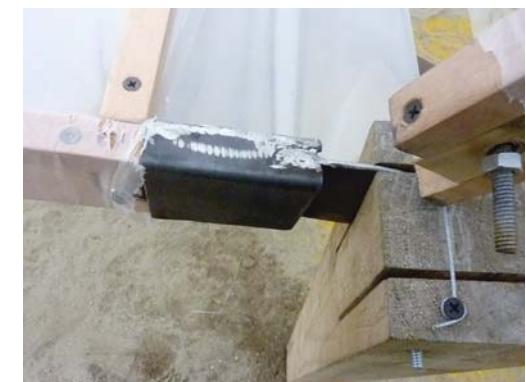
LA CUBIERTA SUPERIOR DESCansa EN EL CUARTON .ESTO NO AFECTA CUANDO LA CUBIERTA INFERIOR SE LEVANTA, YA QUE NO ALCANZA A TOPAR.
