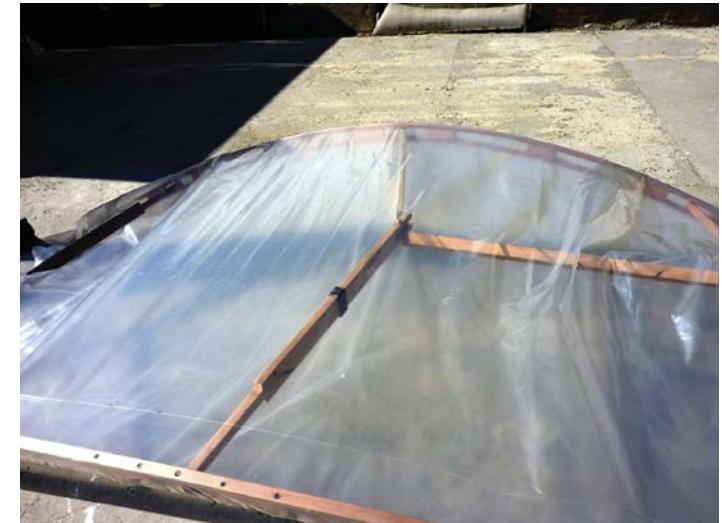
Se tensa en primera instancia la pieza interior central. interior central. la fuerza debe ser letno y se va estirando el polietileno.
