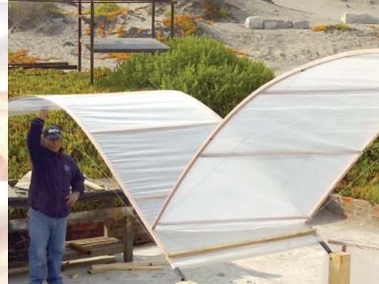
Al levantar una cubierta, se levanta la superior, creando una cadena
