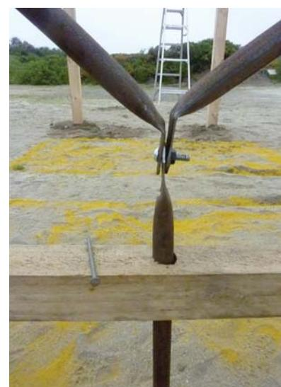
Se sostiene la pieza en el palo porque al hacer la fuerza con la pieza de abertura al levantar la cubierta, la pieza tiende a inclinarse y no se mantiene en su posicion .
