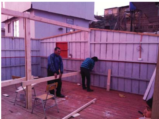
Armado viga principal
