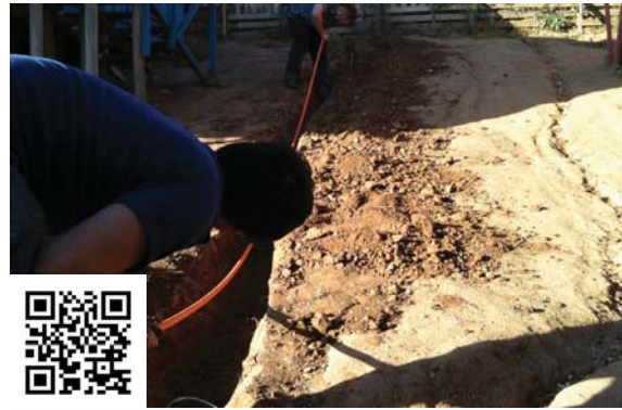
Video instalación de antenas
