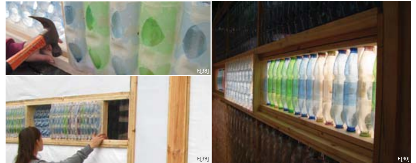
F[38] Fijación de ventanas corredizas al panel.
