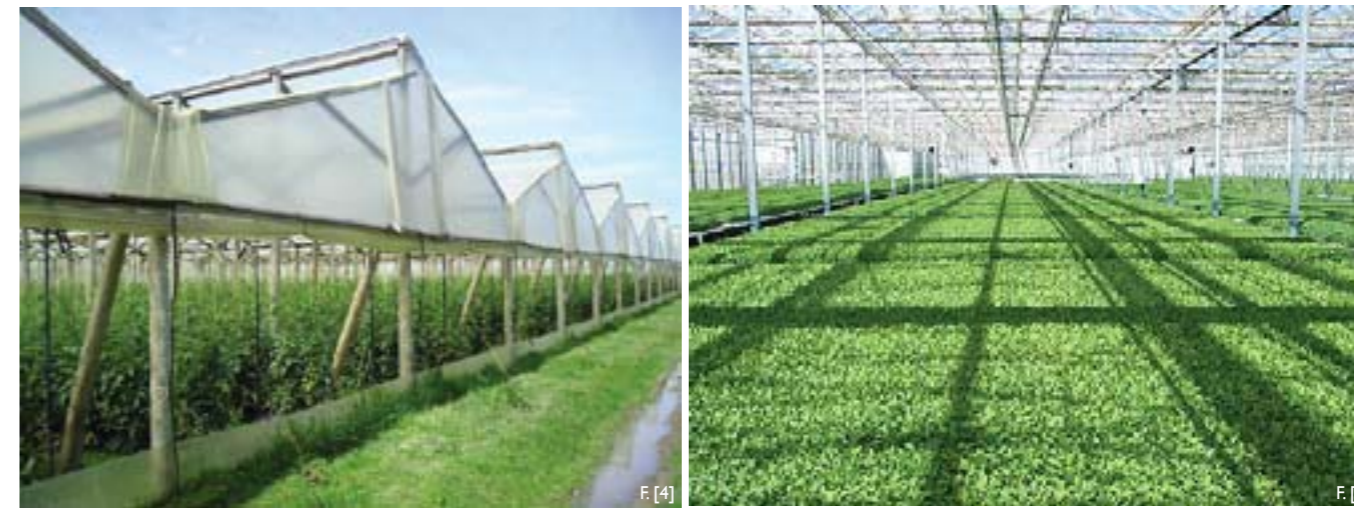
F.[4] Ventilación invernadero “chileno”. F.[5] Interior invernadero “almeriense”.
