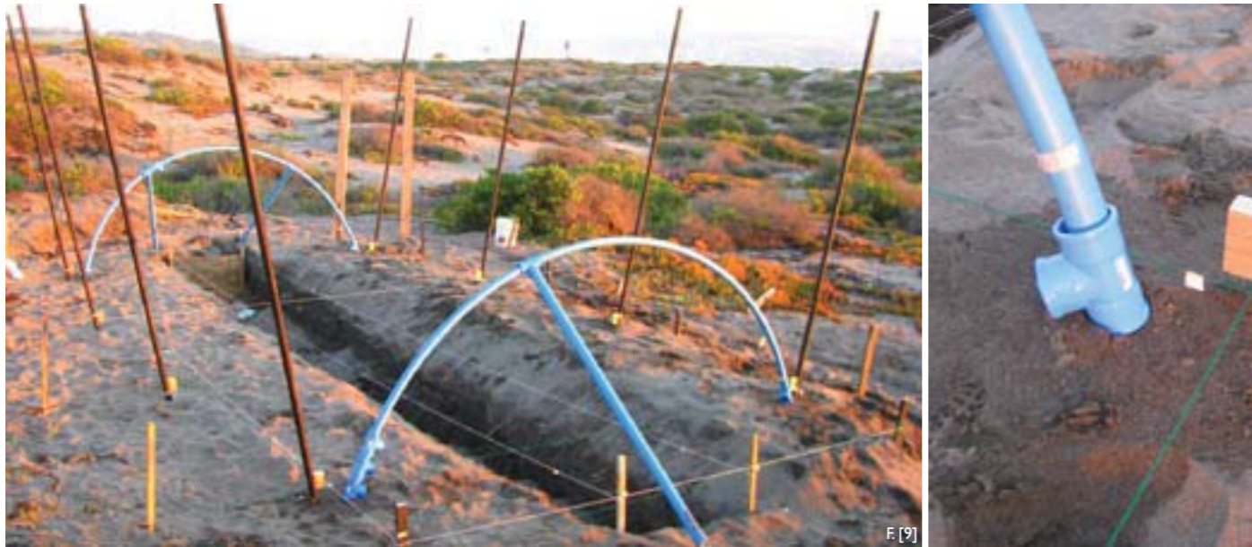
F.[9] Fijación de arcos en el terreno.
