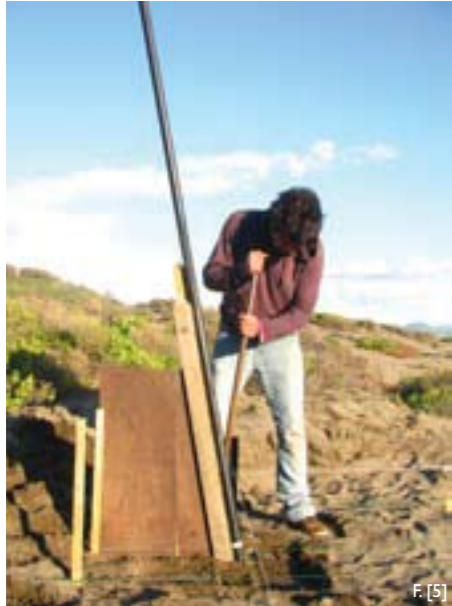
F.[5] Matriz para fijar los pilares. F.[6] Pilares fijos en el perímetro.
