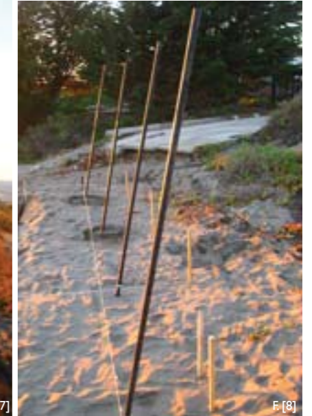
F.[7] Vista frontal de la ubicación de los 8 pilares. F.[8] Pilares de un costado del invernadero con 10^\circ de inclinación.
