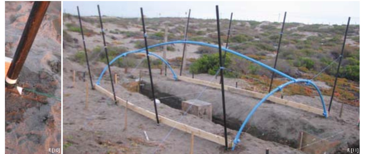
F.[11] Montaje de listones de madera inferiores y viga central.
