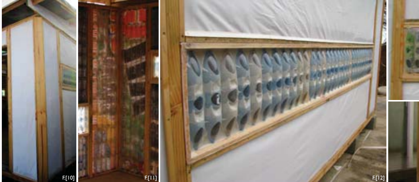
F[10] Panel esquina, vista externa.
