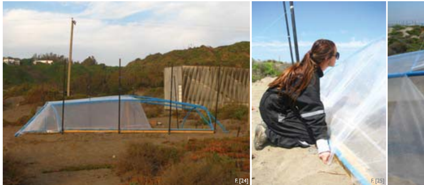
F.[24] Primera sección de polietileno fijada en la estructura.
