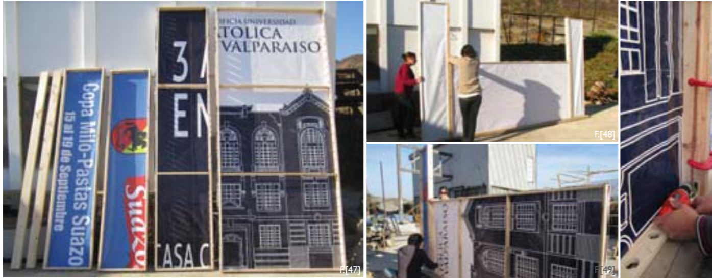
F[47] Paneles para conformar una pared.
