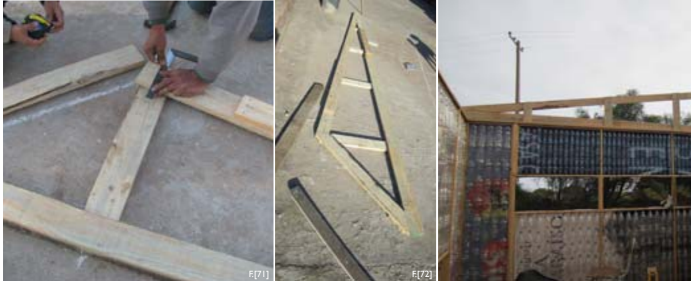
F[71] Construcción de cerchas.
