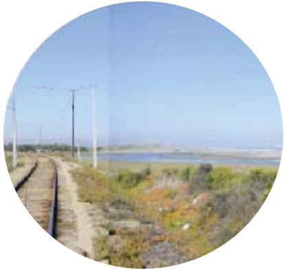
LA CONSTRUCCIÓN DE VÍAS FERROVIARIAS
