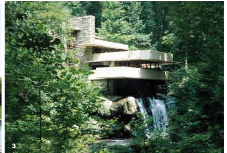
LA CASA DE LA CASCADA (1937)
