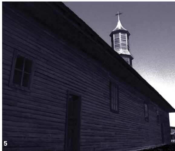
vista hacia el costado de la iglesia
