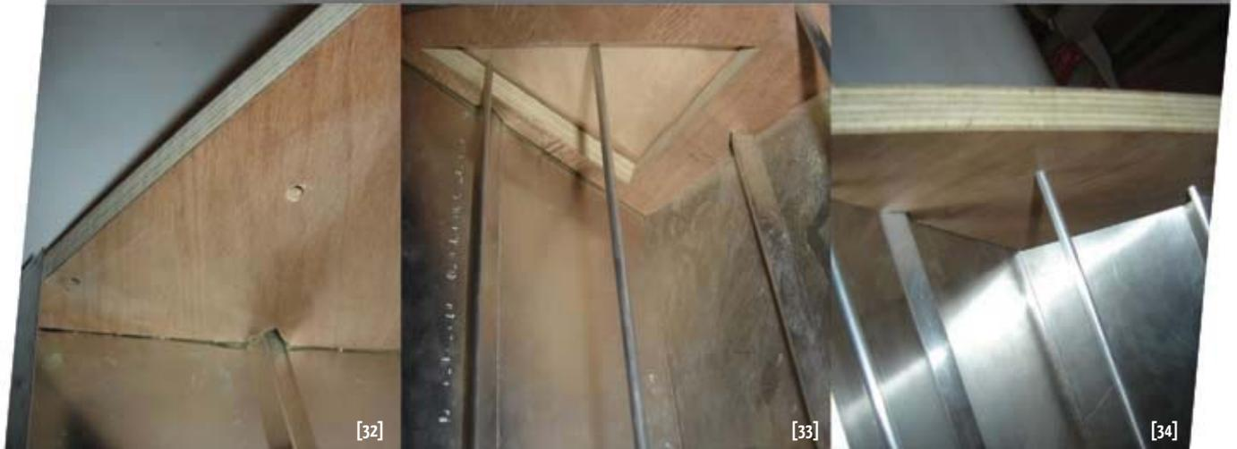
[32] SEMI PERFORACIÓN PARA LA TERMINACIÓN DEL TUBO DE ALUMINIO [33] LLEGADA DE LOS TUBOS A LA PUNTA EXTERIOR DE LOS BRAZOS [34] LLEGADA DE LOS TUBOS A LA PUNTA INTERIOR DE LOS BRAZOS, ESTA PARTE INTERIOR ES LA QUE SE UNE POR BISAGRA DE PIANO A LA COLUMNA
