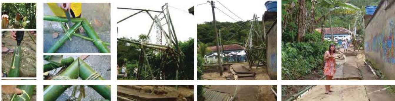
PROCESO CONSTRUCTIVO DE VINCULOS
