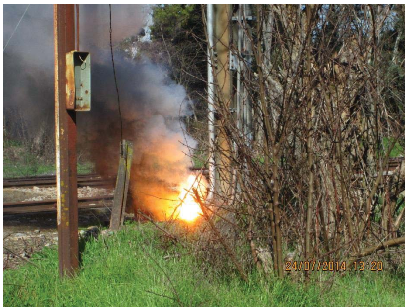
Figura A.5- 5: Pórtico PK260/5 en incineración – Registro fotográfico Empresa SSEC.
