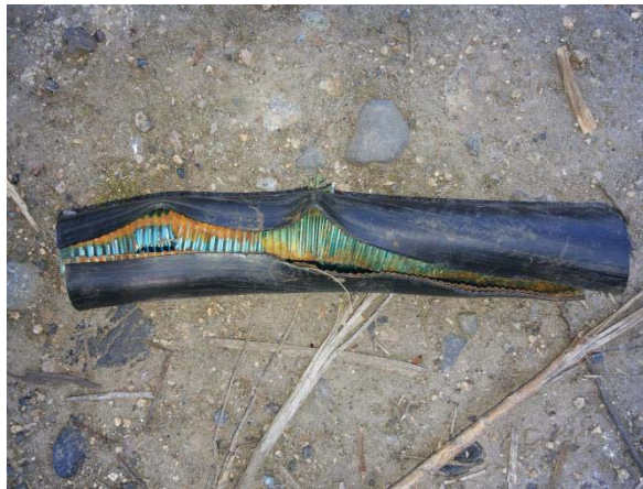
Figura 3-6: Aislaci n de tuber a de bajada, material polietileno reticulado – Registro fotogr fico Empresa SSEC.
