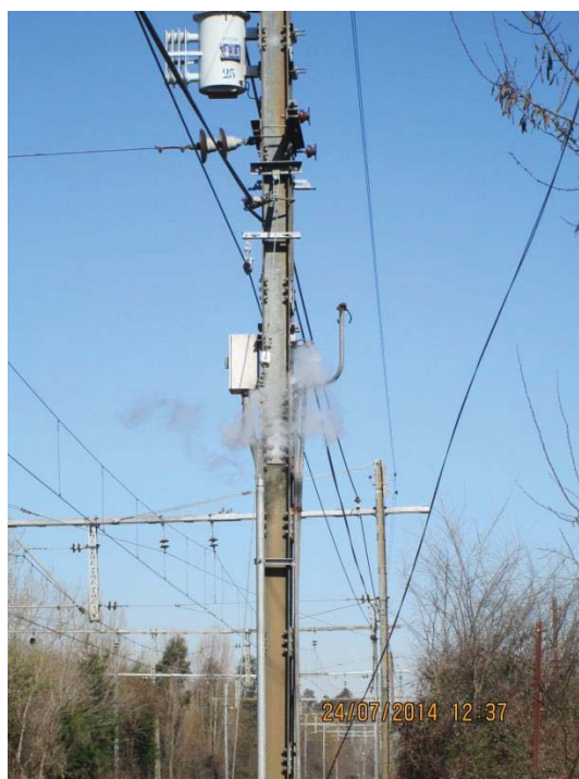
Figura A.5- 1: Emanación de humo de pórtico PK260/5 – Registro fotográfico Empresa SSEC.
