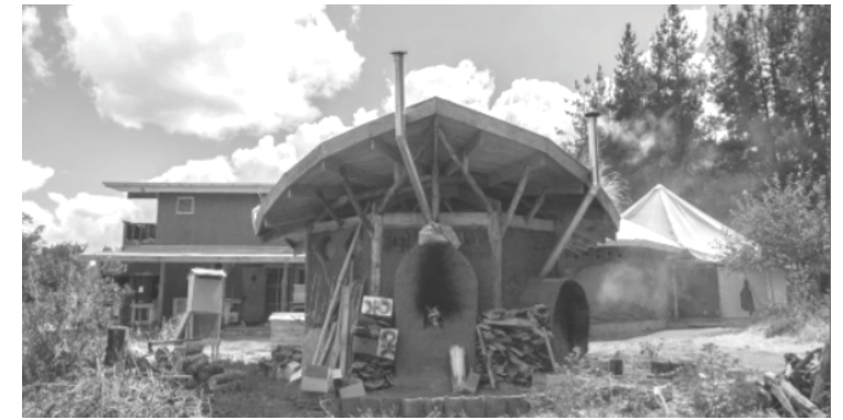
Im. 40. Construcción en barro
