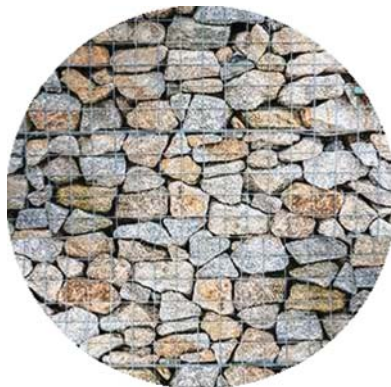
MURO DE GAVIÓN CONTENIDO POR ELECTRO MALLA DE ACERO GALVANIZADO NRO 16
