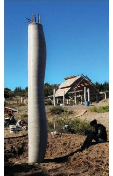
Difieren en cuanto al tiempo, y la estructura interior, ya que en el yeso solo se necesita un alambre tensado al centro, en cambio el hormigón requiere de una estructura de mayor complejidad, cálculo ingenieril, en su enfieradura, trabajo en equipo, este requiere un mayor tiempo de secado
