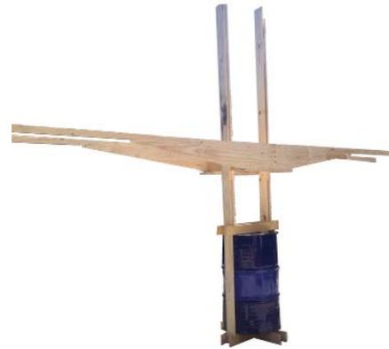
En la contrucción del primer prototipo a escala real, comienzan las realidades constructivas y sus dificultades como el peso y el nivel, que son esenciales para un buen funcionamiento. Se incorporan tensores, y áreas de gran espesor para buen equilibrio.
