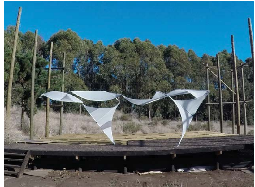
Forma final de la cubierta (manto extendido)
