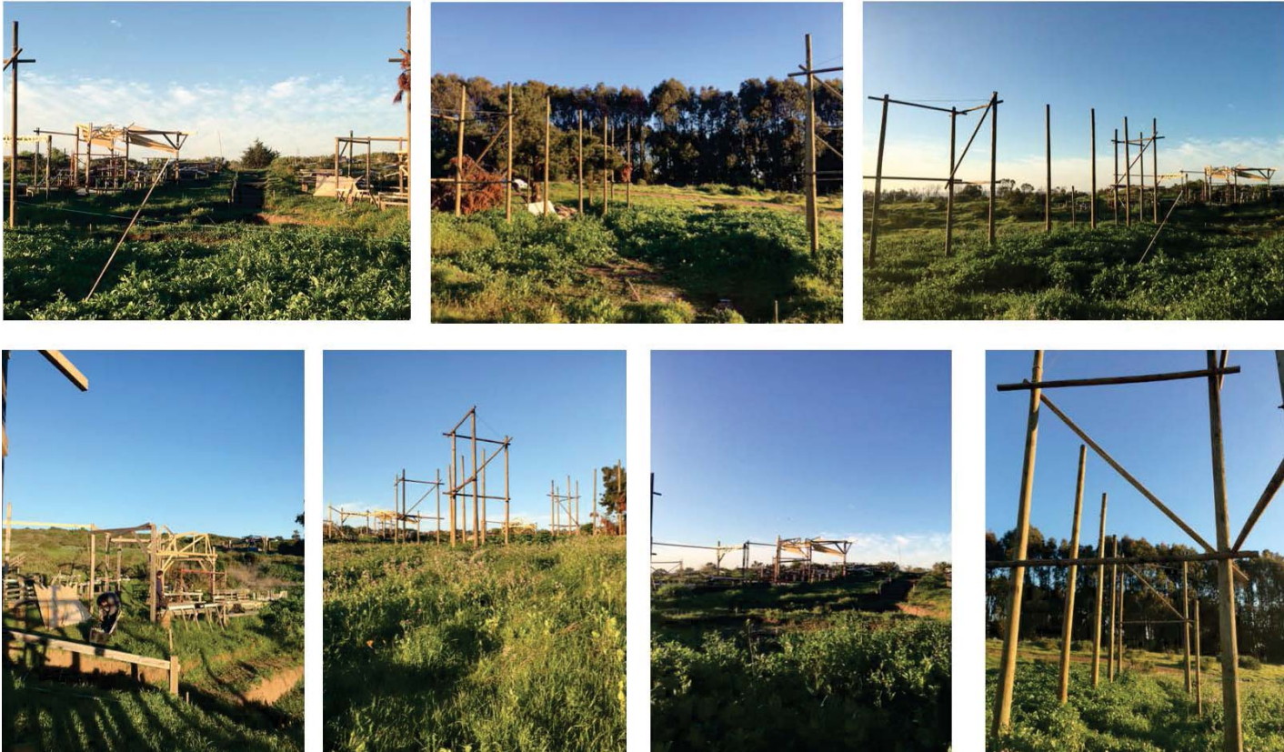
*Compilado fotográfico del lugar de la obra previo a la construcción del escenario
