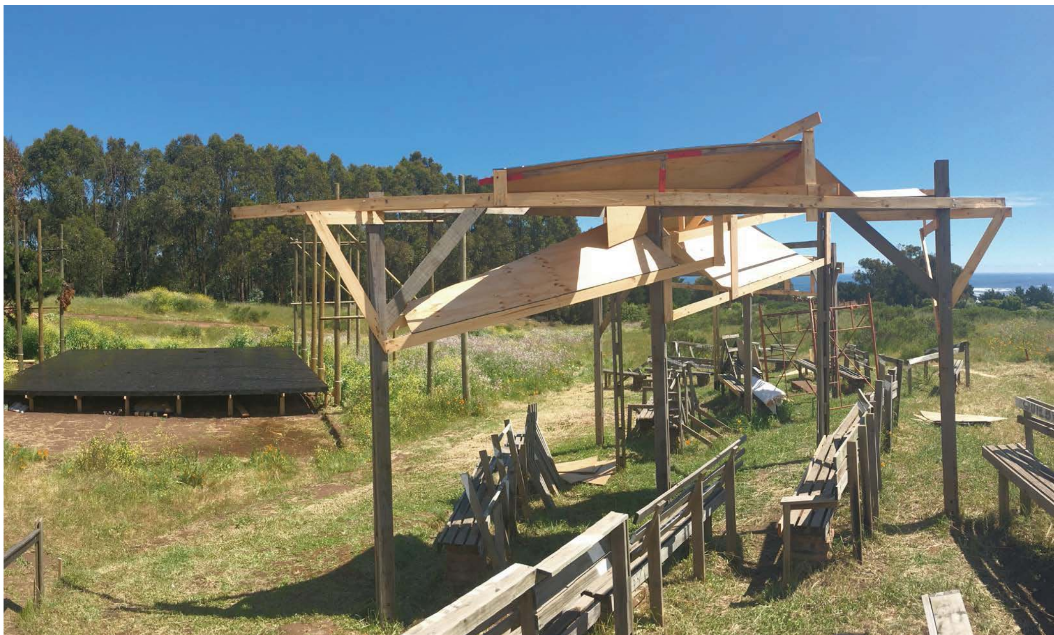
*Fotografía panorámica del lugar de obra
