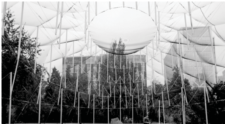
Tensoestructura compuesta por verticales que se van superponiendo
