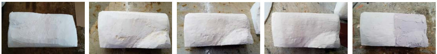
[208, 209, 210, 211, 212] Curva sellada con cola fría, con dos capas de pasta muro sin lijar y luego en la mitad, se le aplica masilla mágica
