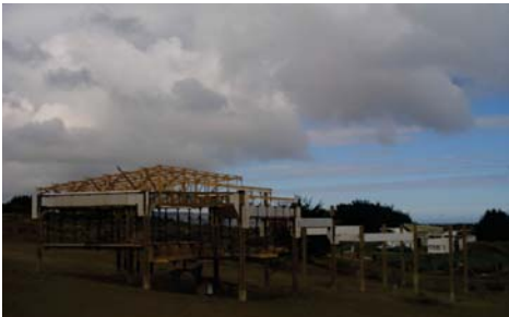
[06] Hospedería Colgante en Construcción (2003)
