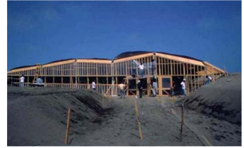
[11] La casa de los Nombres desde fuera, Construcción.
