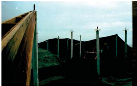
[12] La casa de los Nombres, Construcción
