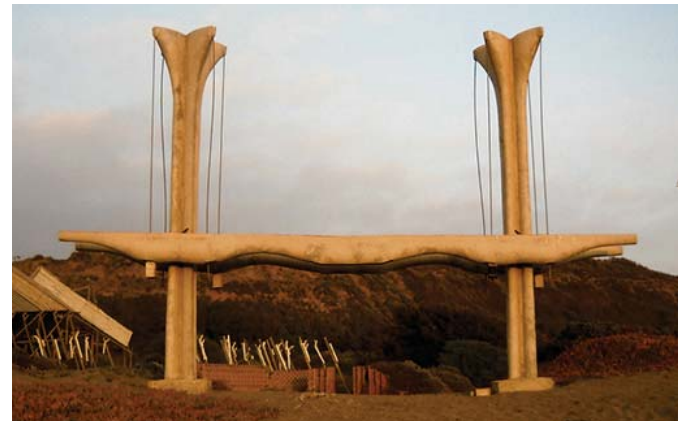
[27] Fotografía de la Obra Pilares de Hormigón
