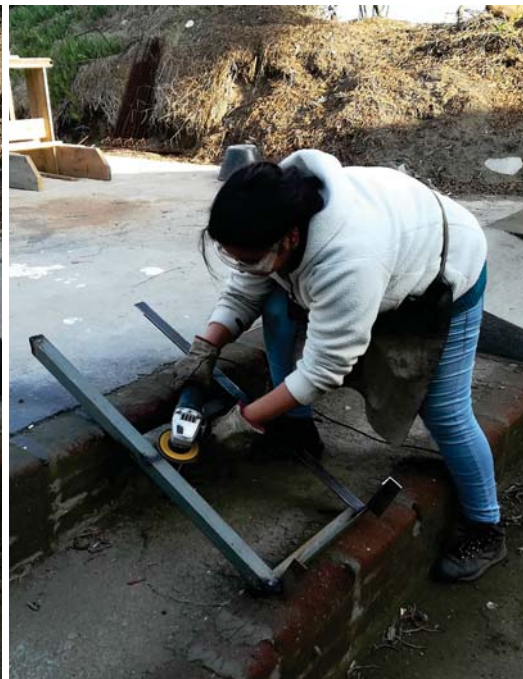
[228, 229] Pulido del soporte completo. Paso anterior a ser pintado con anticorrosivo negro
