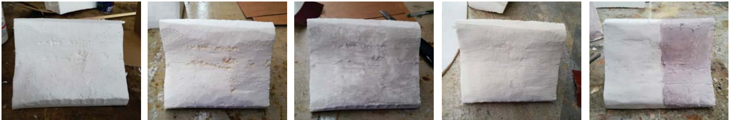
[203, 204, 205, 206, 207] Curva sellada con cola fría, con dos capas de pasta muro lijadas y luego en la mitad, se le aplica masilla mágica
