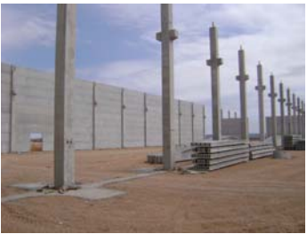
pilares de hormigón armado
