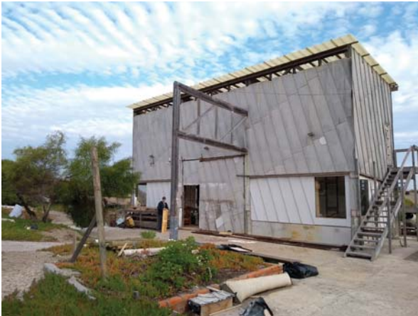
(1) Taller de Obra
