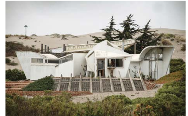
[1] Celdas, obra de la Ciudad Abierta
