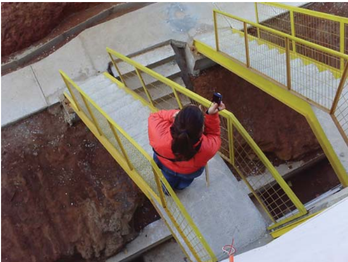
Escaleras de acceso
