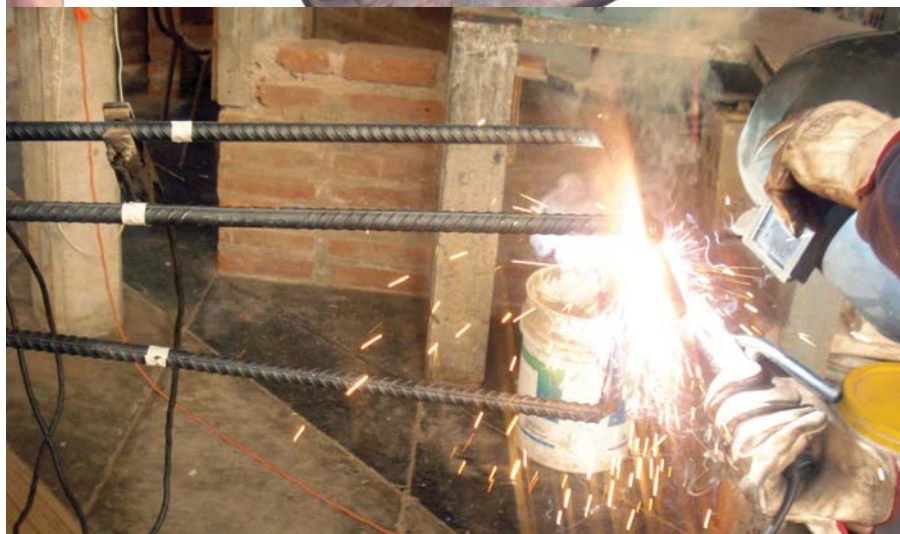
2.- se doblan 3 (uno para cada vértice del prisma) y se soldan los 3 para juntarlos por el extremos doblado
