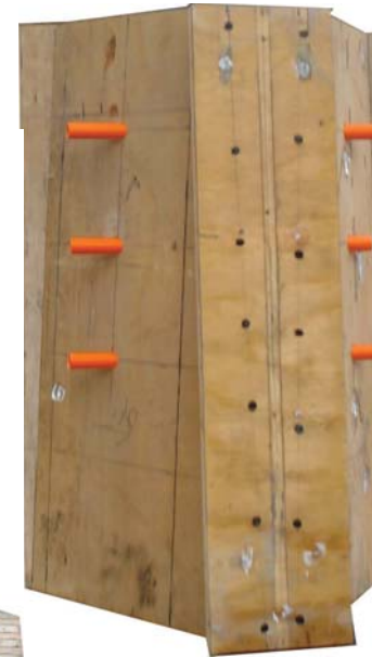
molde para el prisma introducido en la parte inferior del hito, listo, no se coloca tapa, ya que irá sobre la fundación en el terreno
