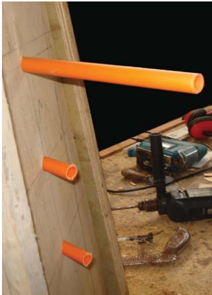
se colocan los 3 tubos, uniendo de a par los 6 orificios hecho anteriormente
