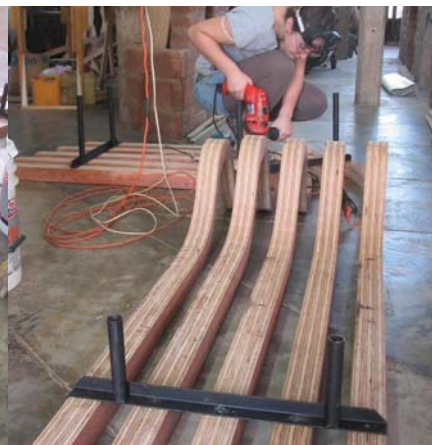
Se fijan con tornillos de madera de 1½"
