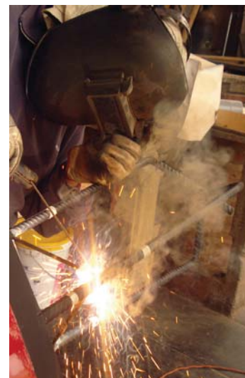
3.- se solda un triángulo en el otro extremo, para mantener las distancias entre ellos
