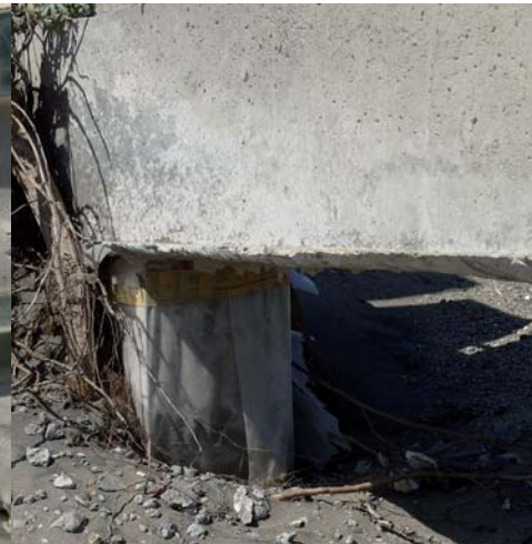
El viento descubre la estructura enterrada en la arena.
