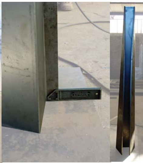
se comprueba la verticalidad
