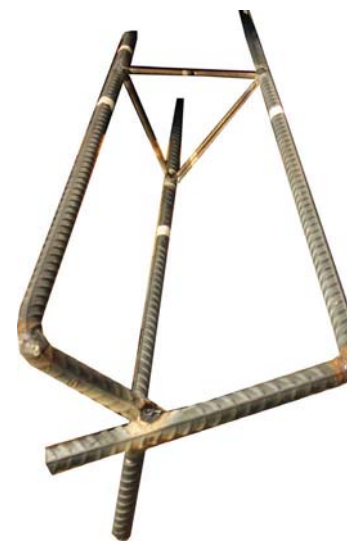
4.- queda la estructura de armado para unir la fundación aislada y el prisma introducido en la estructura
