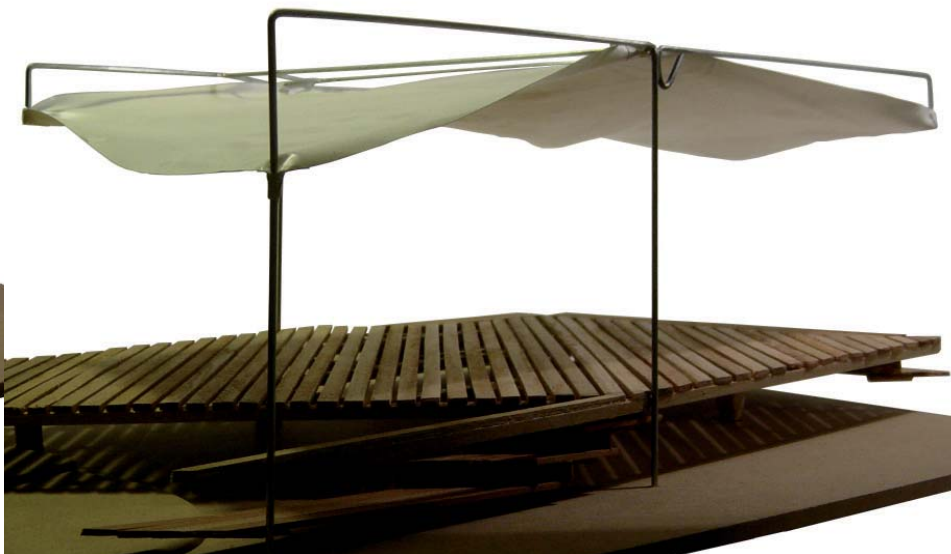
Telas toldo suspendidas con tensores
