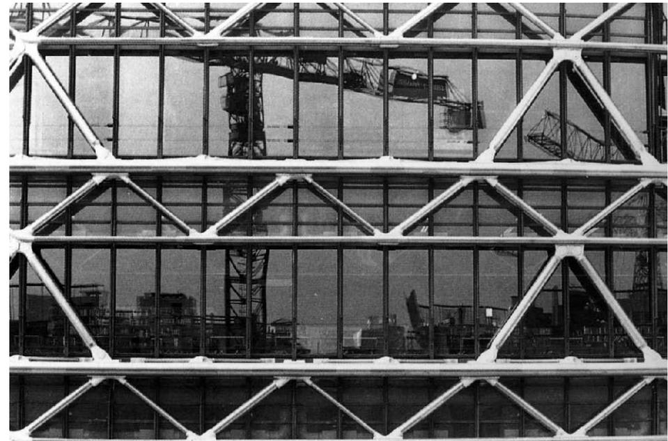
La estructura reticulada compuesta de 2 tipos de vigas que a partir de uniones compartidas se van conformando como malla homogénea, pero que a su vez permite intercalar un vano mayor.
