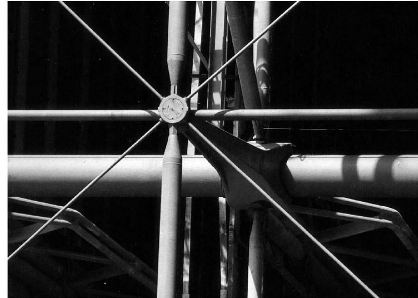
Detalle de la esquina donde aparecen los encuentros articulados y las distintas secciones utilizadas, su diversidad en los elementos diferenciando los esfuerzos según tracción, flexión o compresión. Es por otra parte la manifestación de que se está trabajando con trazos discontinuos y es ahí donde el nudo se vuelve un pormenor, entendido este como el fragmento que dice del total.
