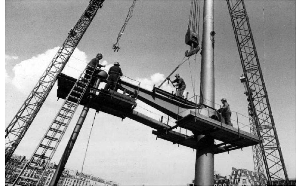
Montaje de los brazos que sostienen la estructura de la fachada. El sistema debe vérselas con el proceso constructivo, el orden de su puesta en obra, a pesar de ser elementos prefabricados la obra no se erige en un orden lineal como podría darse en una placa estereométrica, si bien el proceso es mecánico, este se da más bien como una sumatoria de elementos que van conformando elementos mayores hasta que finalmente quedan vinculados al total.
