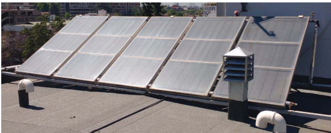
Figura 4-9: Imagen de los paneles en la planta superior.
