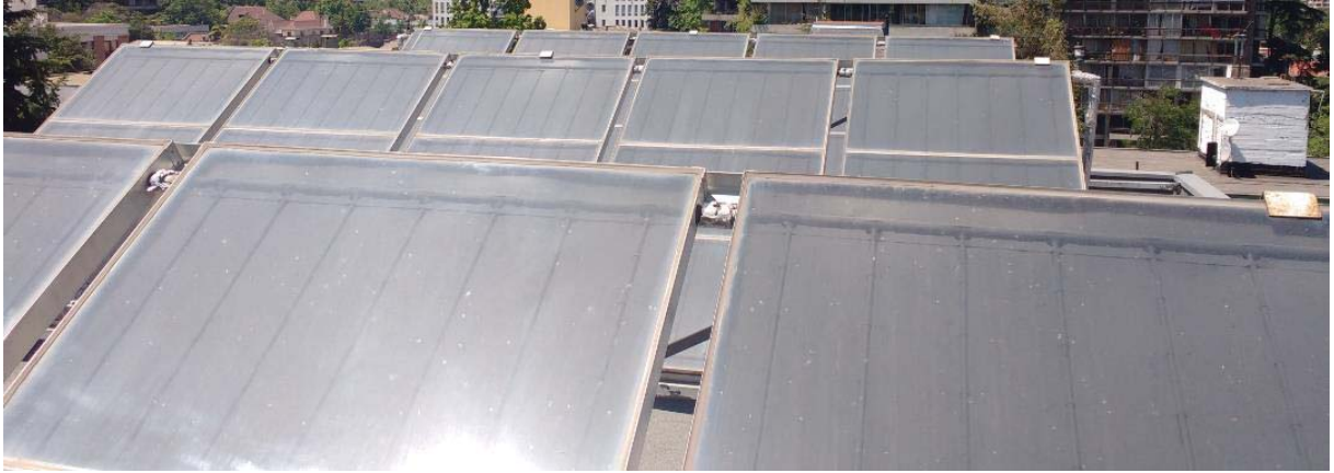
Figura 5-4: Fotografía de los paneles en la cubierta superior
