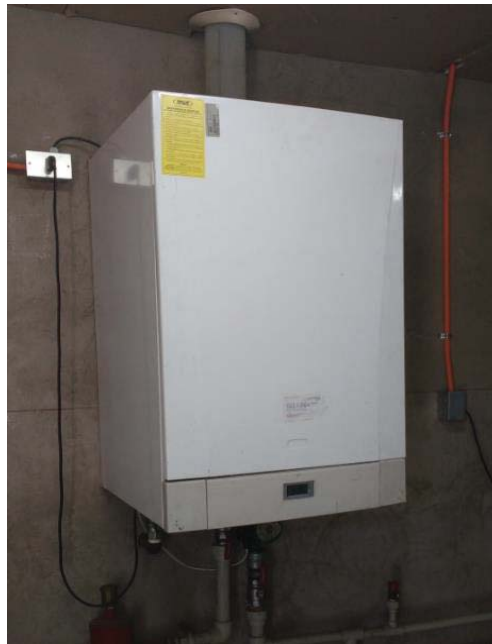
Figura 5-8: Caldera de la instalación
