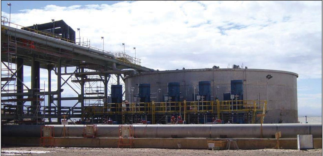
Figura 12 Estación de Bombeo PLS y Estanque.
