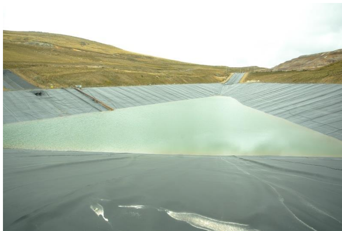
Figura 1-1 Piscina acumuladora de electrolitos (PLS)
