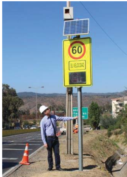
Figura 1-1: Radar de velocidad instalado en Ruta las Palmas (Fuente: www.soychile.cl )
