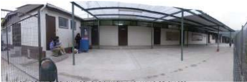
IMAGEN DE LA EXTENSION DEL PATIO HACIA LAS AULAS DE CLASES
