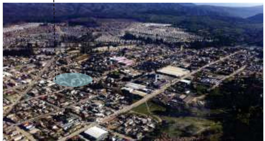
IMAGEN AEREA DE PLACILLAS, VALPARAISO. FUENTE MAX CRICHTON
