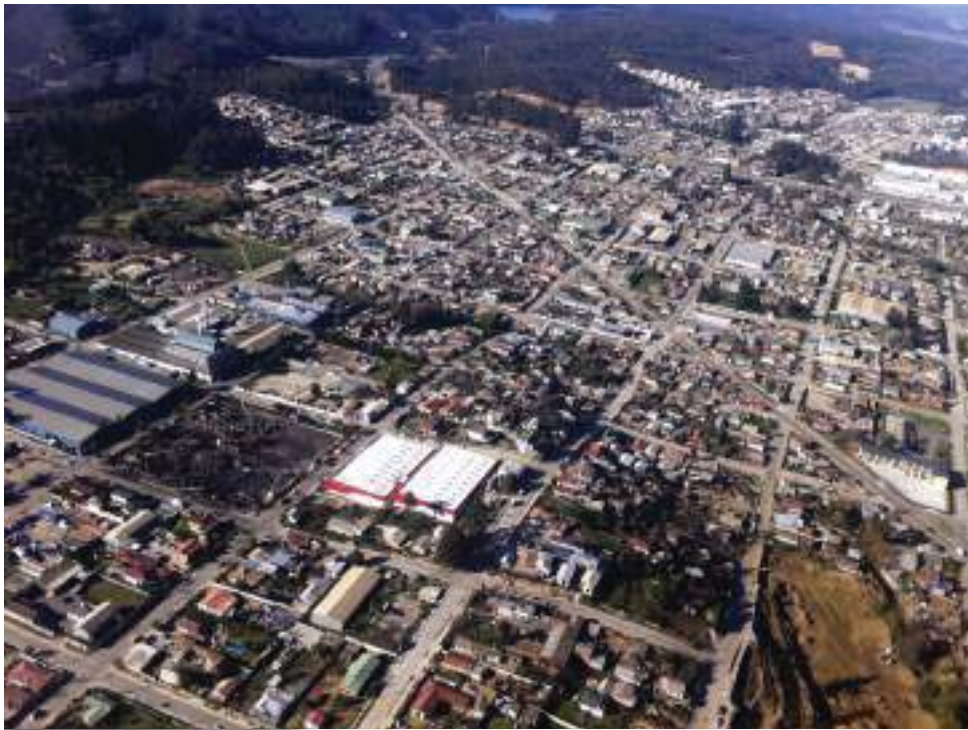
FOTOGRAFIA AEREA DE PLACILLAS
