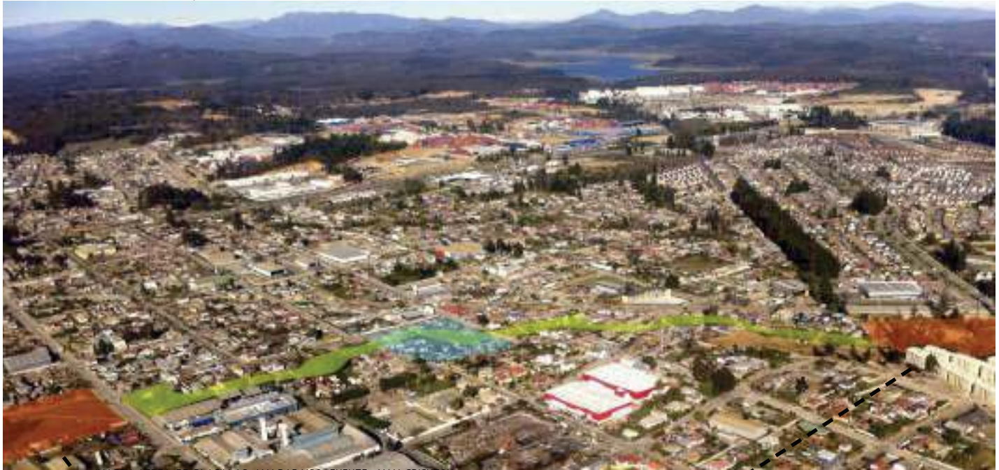
IMAGEN AEREA DE PLACILLAS, VALPARAISO. FUENTE: MAX CRICHTON
