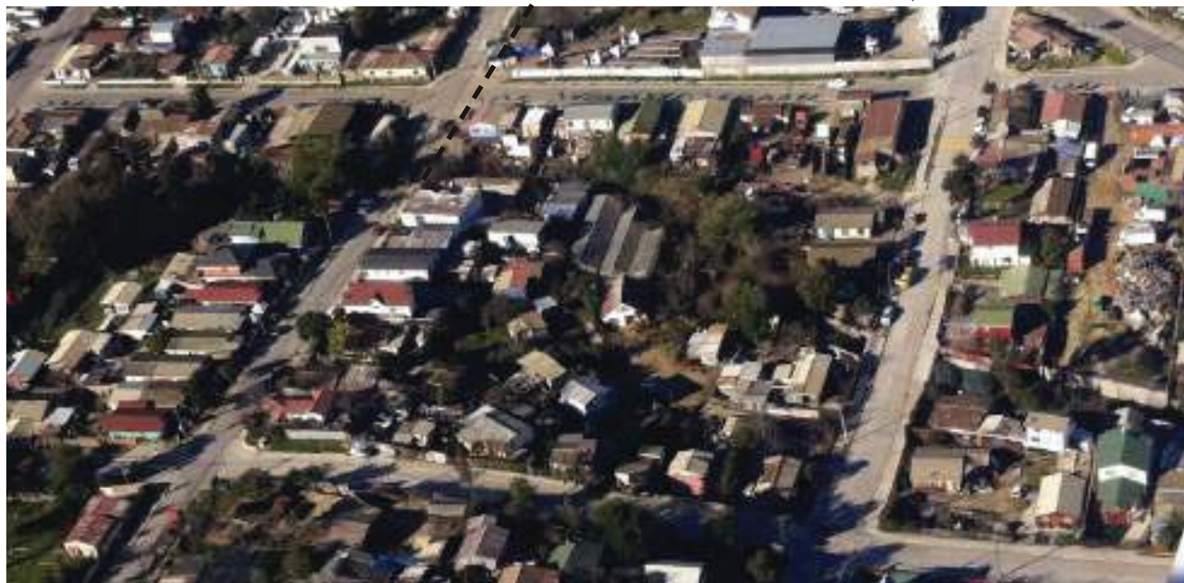
IMAGEN AEREA DE PLACILLAS, VALPARAISO. FUENTE MAX CRICHTON
