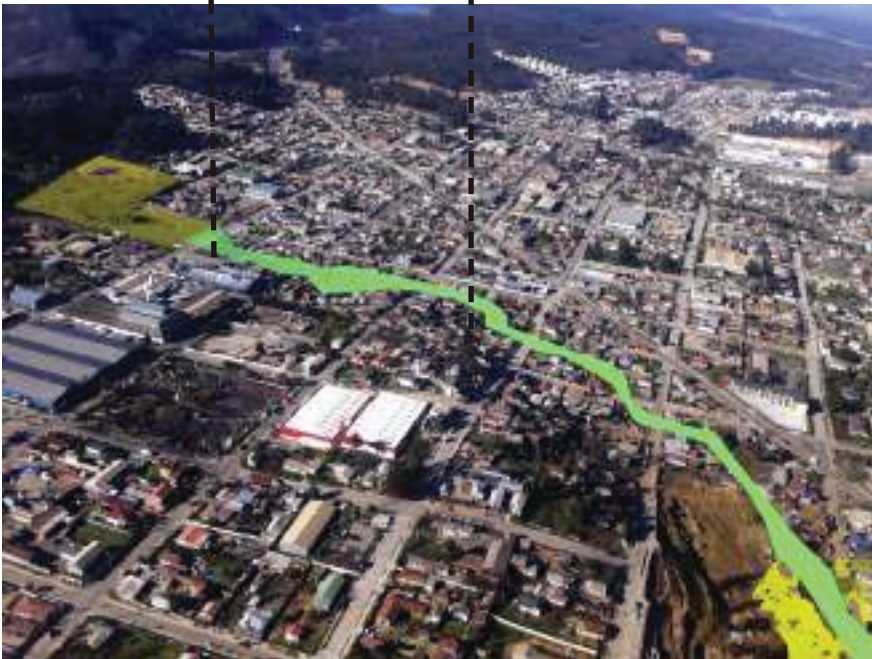
IMAGEN AEREA DE PLACILLAS, VALPARAISO. FUENTE MAX CRICHTON
