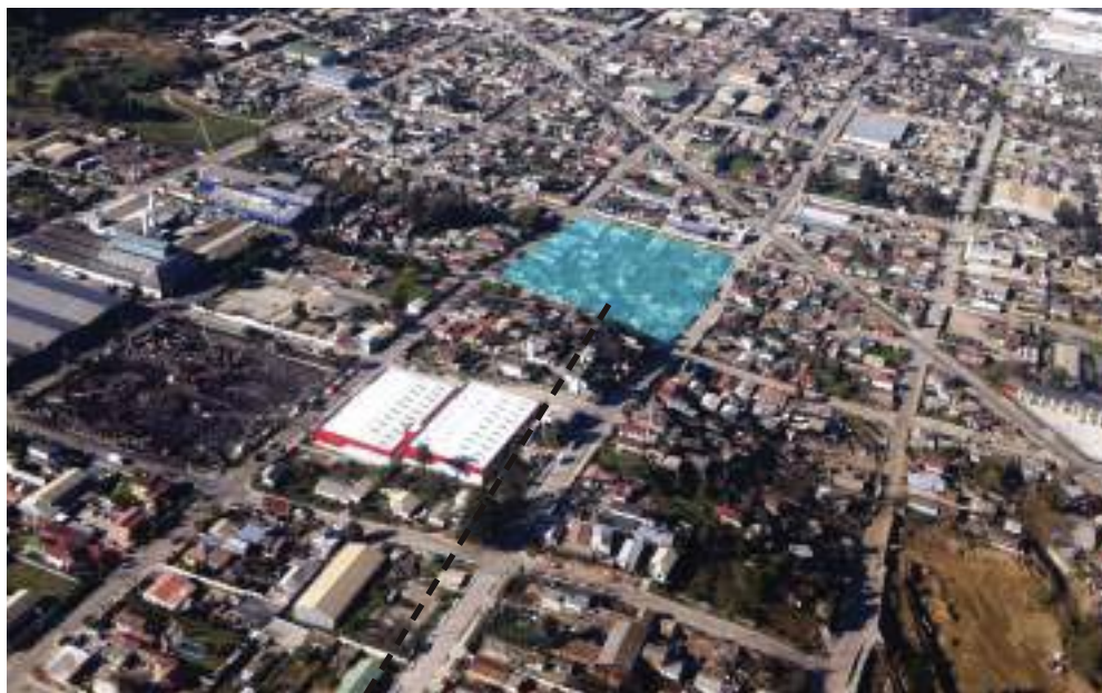
IMAGEN AEREA DE PLACILLAS, VALPARAISO. FUENTE MAX CRICHTON
