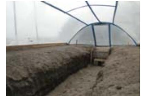
Pasillo de 770 cms de largo compuesto de pastelones y ladrillos, acceso mediante 4 escalones en cada extremo hechas de botellas, muro de contención de 40 cms de alto de botellas PET a ambos lados del pasillo, sobre la que se posa barrera de madera de 29 cms de alto sostenida por 18 listones verticales de 72 cms de 2x2" aperrnados al muro de botellas mediante una variación de la botella ladrillo con un hilo de  $\frac{1}{4}$ ".
