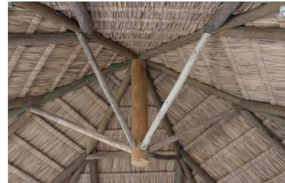
EL PILAR VERTICAL DISTANCIA LAS UNIONES DEL PUNTO PRINCIPAL QUE RECIBE MUCHOS ESFUERZOS, GENERANDO NUEVAS UNIONES MAS ABAJO DEL VERTICE, QUE REFUERZAN LA ESTRUCTURA
