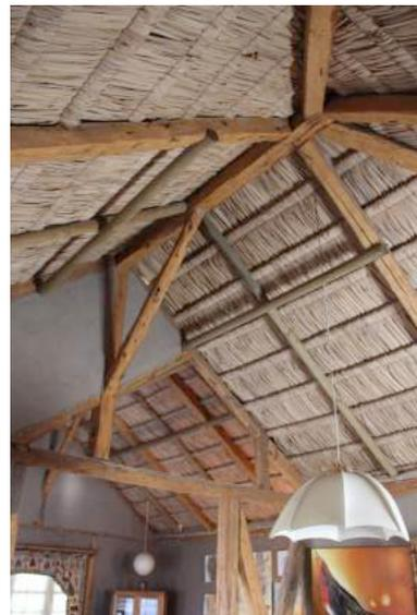
EN EL TECHO DEL COMEDOR, SE UTILIZA UNA DIAGONAL PARA EL APOYO DE LA VIGA PRINCIPAL
