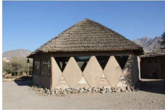
TIPO DE MURO CONSTRUIDO POR LAS DIAGONALES, DEJAN LAS VENTANAS DE FORMA TRIANGULAR SOLO COMO ENTRADA DE LUZ
