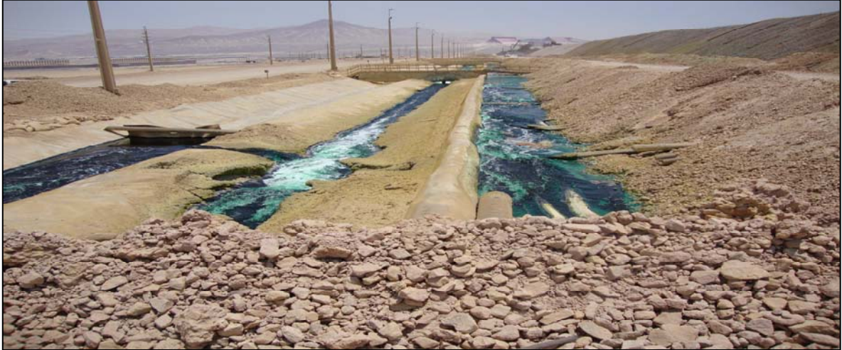
Figura 2.5: Canaleta recolectora de PLS.
