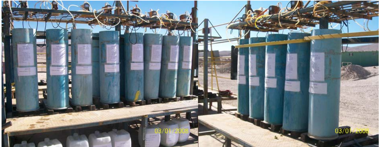
Figura 4.2: Fotografía del montaje de los equipos.
