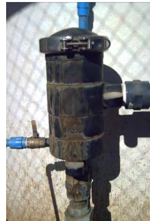
Figura 3.7: Filtro de anillas
