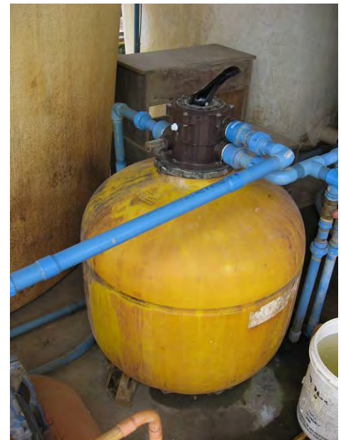
Figura 3.11: Filtro abatidor de Fe y Mn
