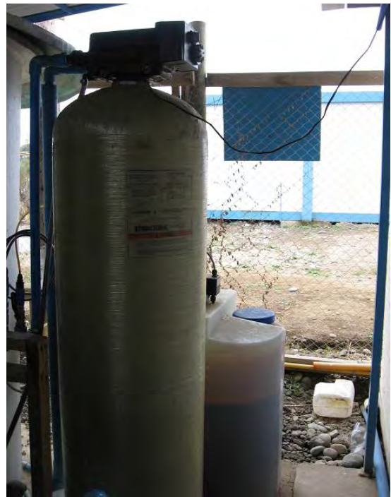
Figura 3.13: Segundo filtro abatidor
