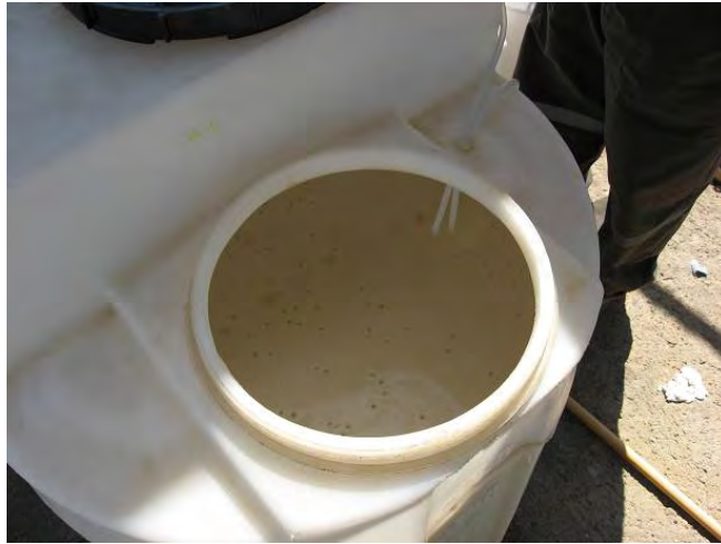
Figura 3.15: Sombrero formado por coloides en el estanque de cloro
