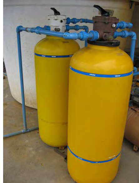
Figura 3.10: Filtro abatidor de turbidez
