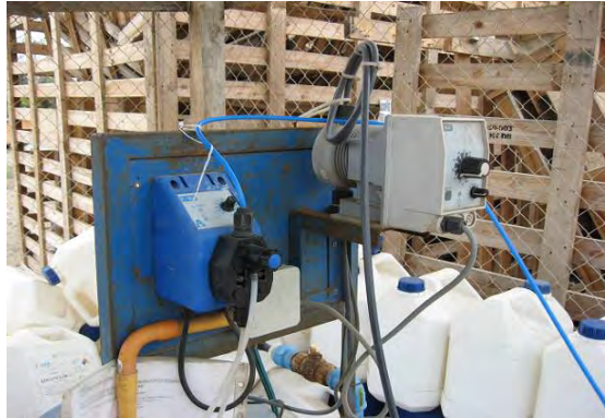
Figura 3.5: Bombas dosificadoras
