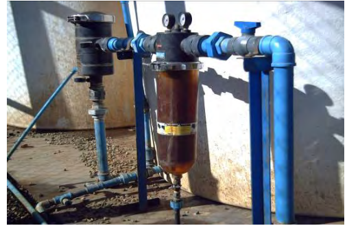
Figura 3.6: Filtro centrífugo
