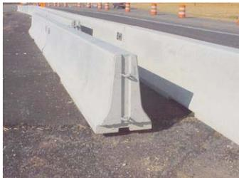
Desde la observación de este tipo de barreras surge la idea del transporte de los monolitos y de la evacuación de las aguas dentro del paseo. Además de ello cumple con la función de barrera de contención de similar modo al ser ensambladas una tras otra linealmente.
