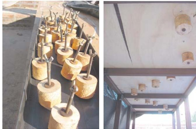
Piezas tensoras y sujetantes de la malla geotextil para formar la curvatura.
