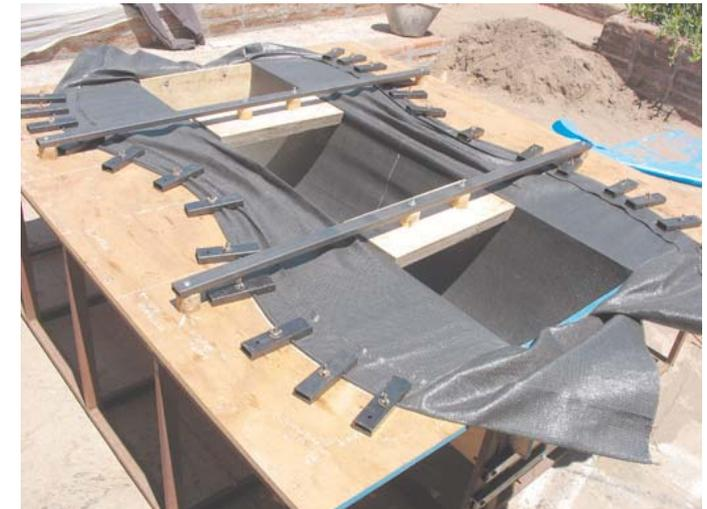
Para solucionar el modo del traslado de las piezas monolíticas hasta el lugar de la obra y de la evacuación de aguas de los pavimentos del paseo se pensó en un sistema dual que sirviera para ambas situaciones desde la construcción del moldaje.
