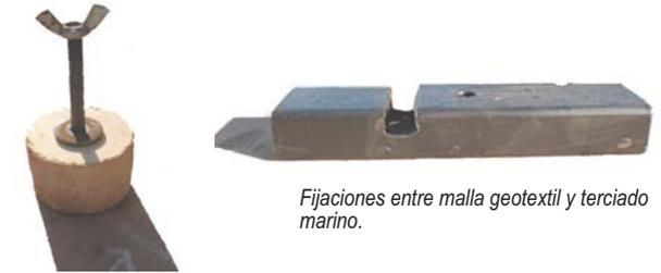
Fijaciones entre malla geotextil y terciado marino.
