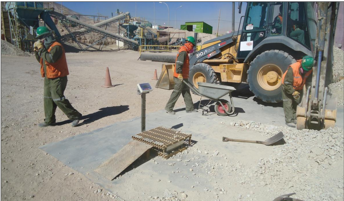
FIGURA 50: Carga de mineral a balde de brazo de excavadora.
