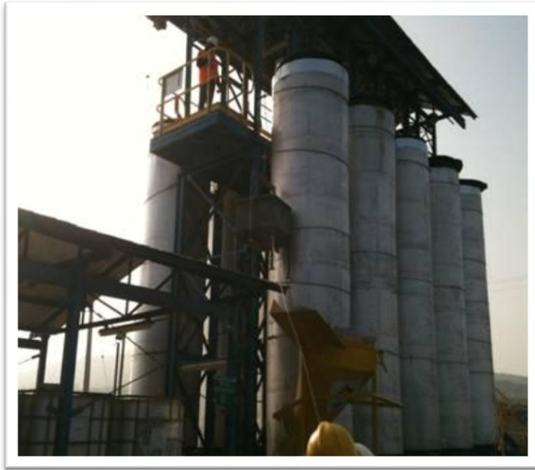
FIGURA 15: Ilustración de planta Huechún, al momento de carguío de columnas.
