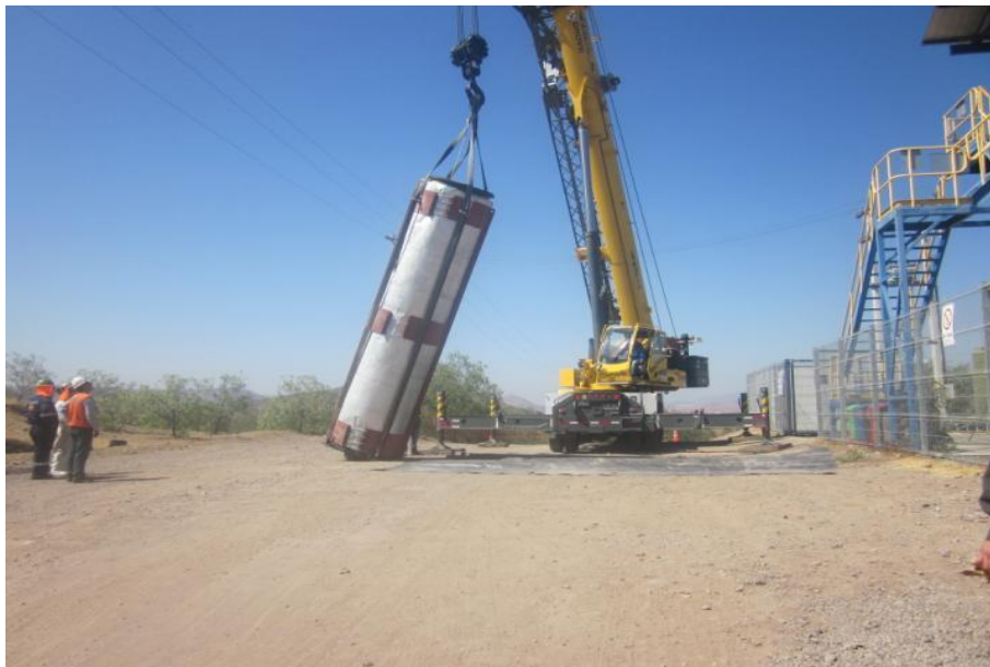
FIGURA 18: Descenso de columna de 6 metros.
