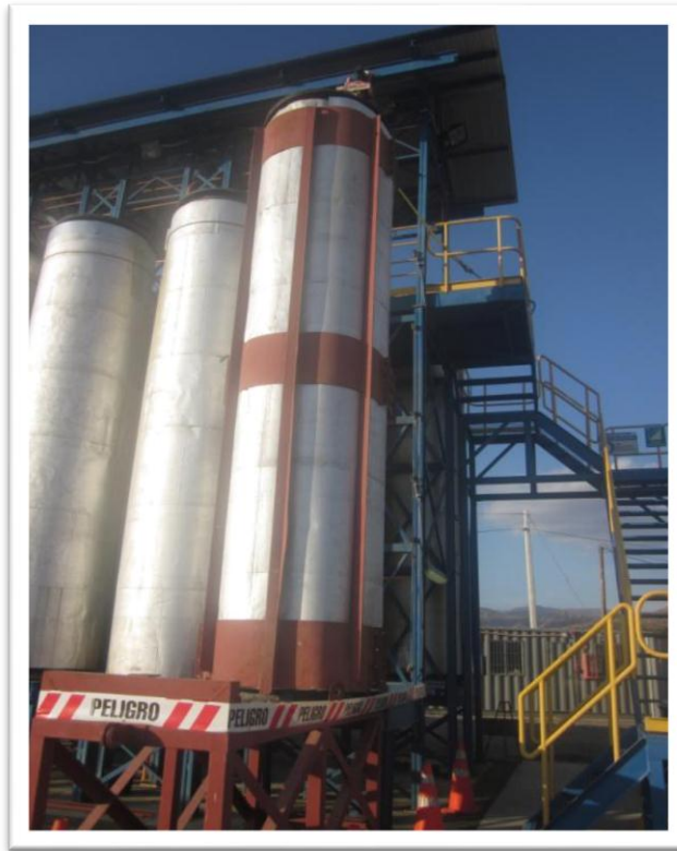
FIGURA 17: Monturín instalado en columna, para realizar izaje de columna.
