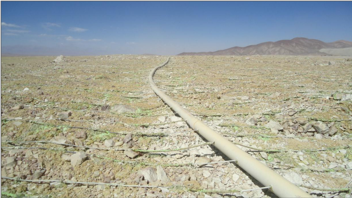
FIGURA 31: Corona de pila ROM, (Malla de riego) - Radomiro Tomic, Chile.
