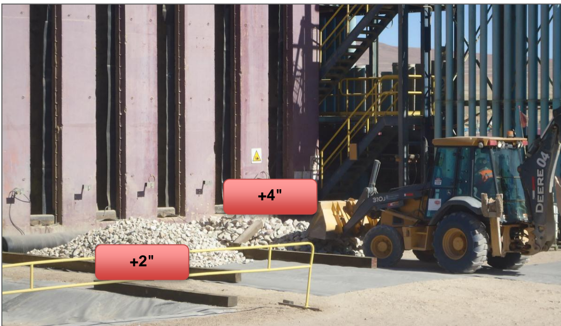
FIGURA 46: Acopio mineral +4" y +2" (mineral OBL 6").
