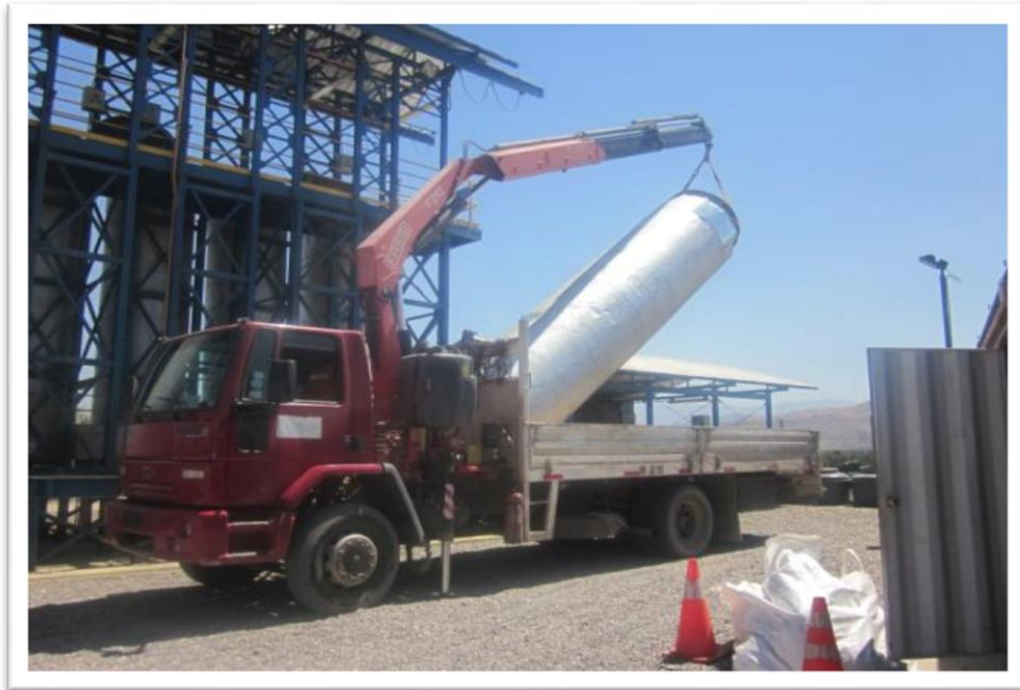
FIGURA 20: Descarga de mineral en camión pluma.
