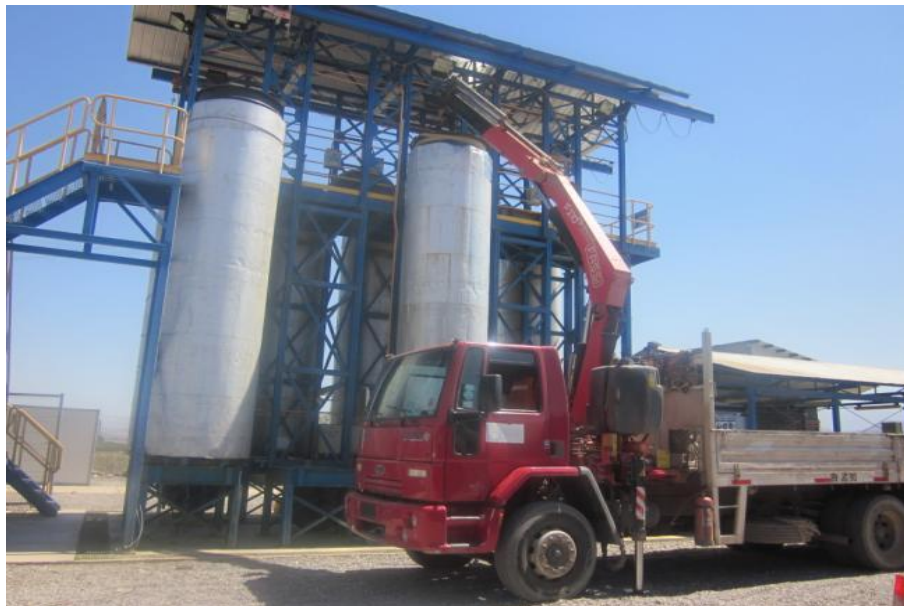
FIGURA 21: Posicionamiento de columna en estructura de pruebas en serie.
