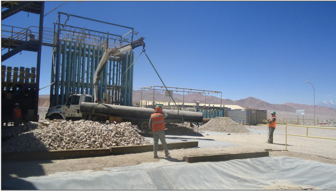
FIGURA 48: Preparación de superficie con carpeta HDPE.
