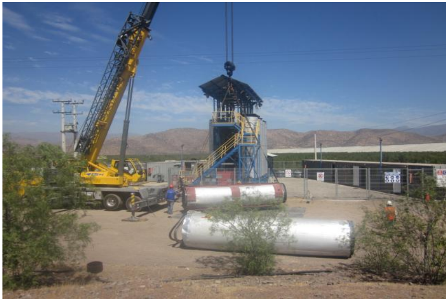
FIGURA 19: Izaje de columna a camión tolva.
