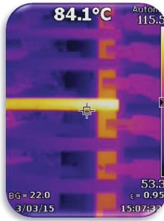
*Figura 29: Cortocircuito observado con una cámara termográfica*
