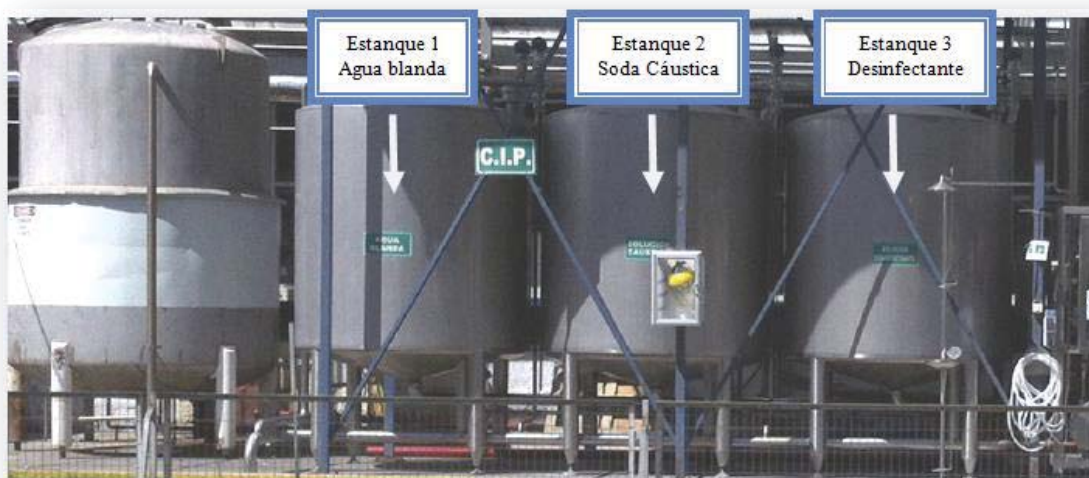
Figura 39. Sistema de Preparación de un Saneado CIP en Planta Cachantun.
