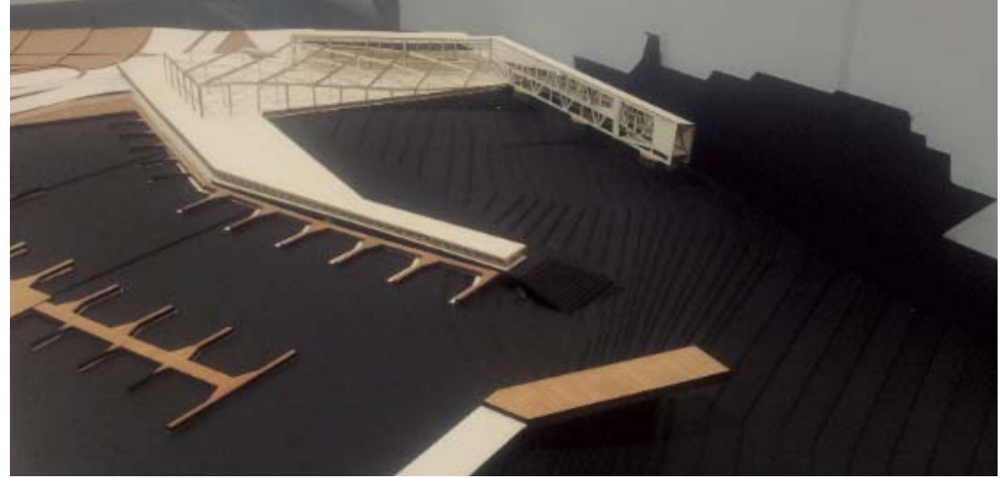
Fig. 87 Detalle muelle flotante al frente y pasarela de embarque en tercer plano. Maqueta escala 1:200 Fuente: Registro del autor.
