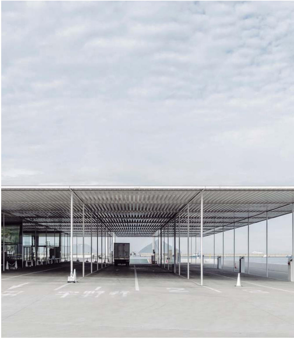
Fig. 33 Acceso embarque de vehiculos Terminal de Ferries de Naoshima. La espera es bajo cubierta, un interior en un exterior.
