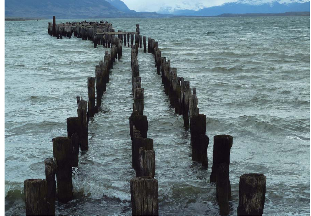
Fig. 53 Olas generadas por el viento. Costanera de Puerto Natales.
