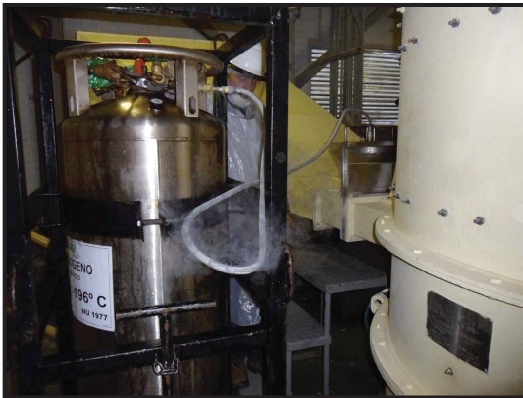
Figura 42. Contratista de Praxair regulando el ingreso de nitrógeno al sistema.
