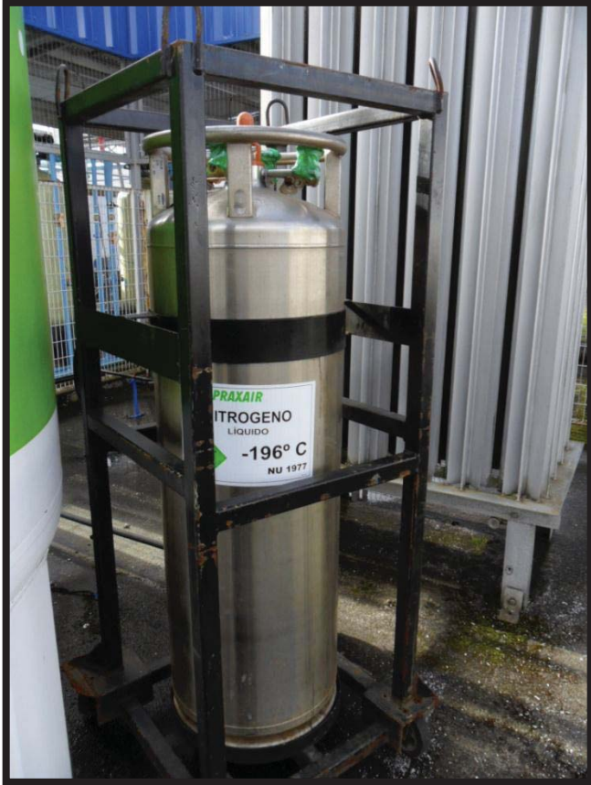
Figura 39. Fotografía del termo de nitrógeno líquido, almacenado junto al tanque de nitrógeno líquido de la planta, en el lugar de contención de sustancias criogénicas.
