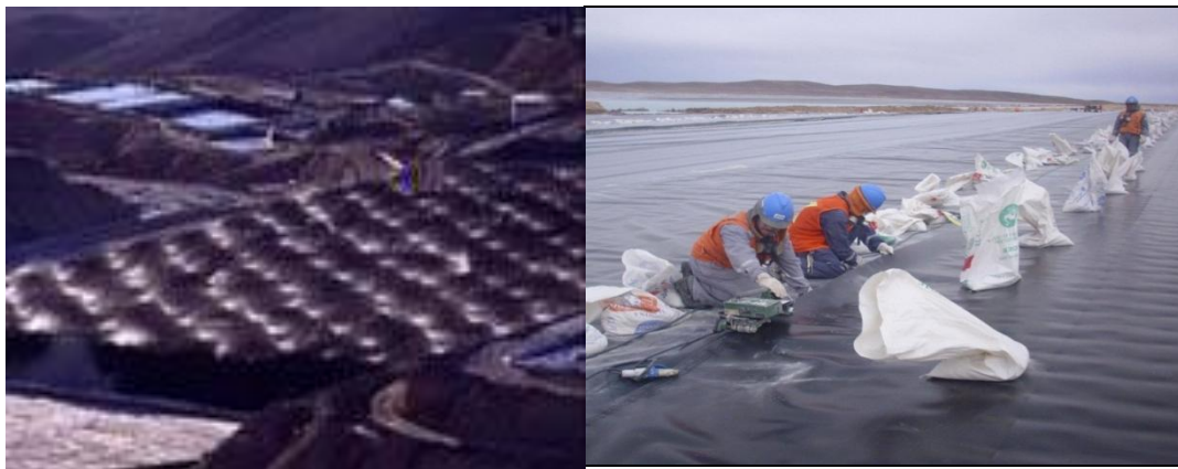
Figura 3.5: Impermeabilización del terreno base de las pilas.
