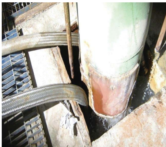
Figura 3.1: Reposición Circuito Primario
