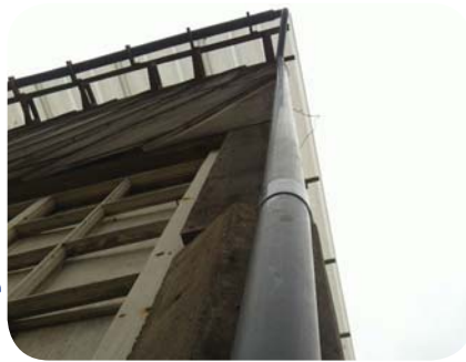
f. Instalación bajada de agua y desague
