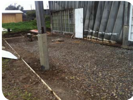
g. Preparación terreno y encofrados
