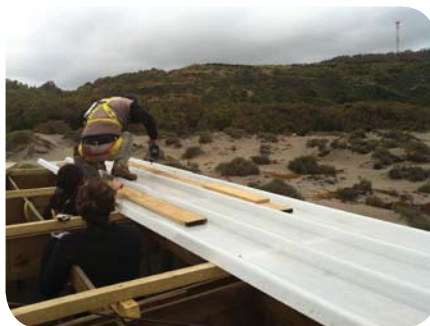
d. Instalación planchas de Poliacrilato
