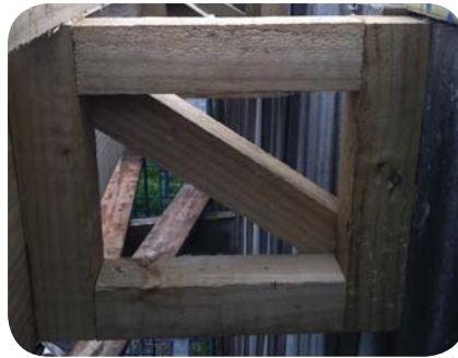
b. Construcción alero fachada poniente
