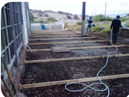
h. Vaciado hormigón
