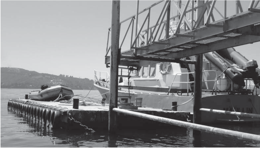
Figura 148. Rampa en mal estado no llega a la plataforma
