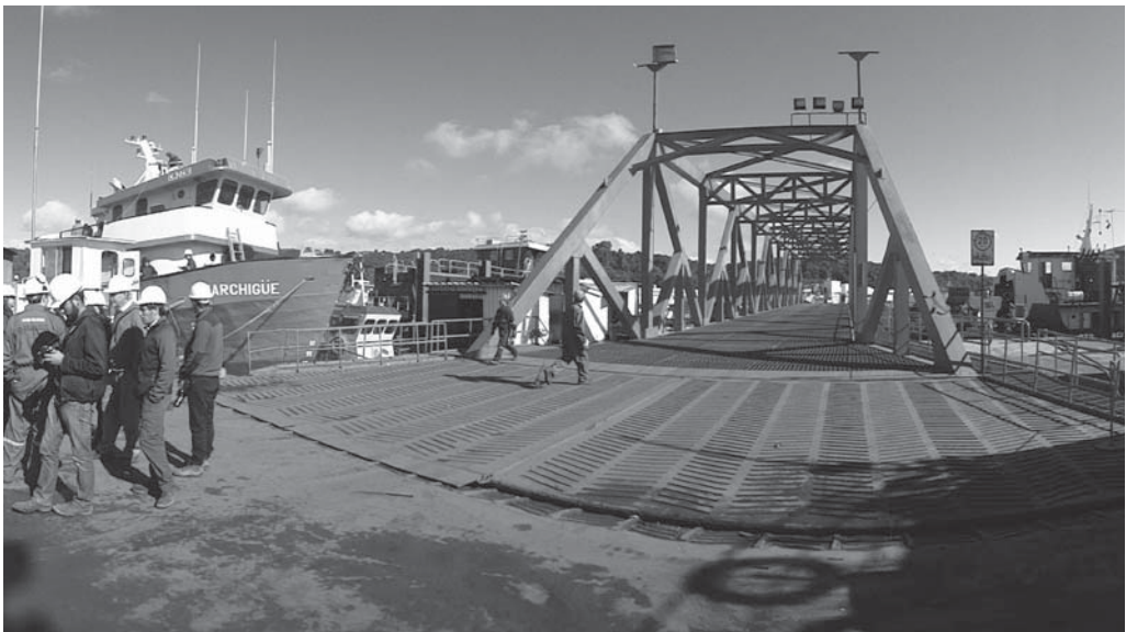
Figura 161. Plataforma flotante de acero y acceso por una rama metálica a la plataforma
