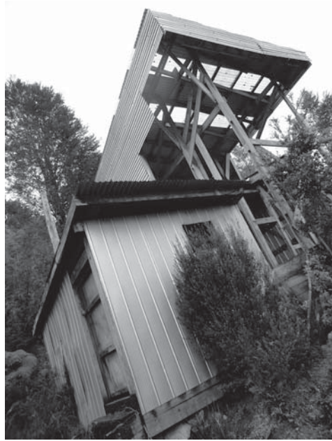
Figura 150. Exterior de la obra. Aparece la escultura realizada
