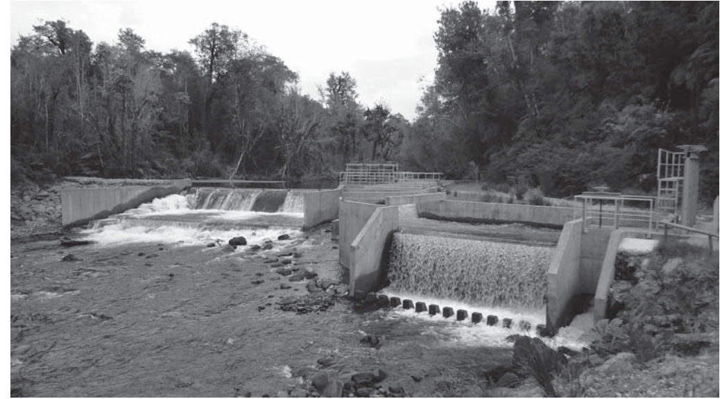
Figura 149. Central de paso en Hornopiren
