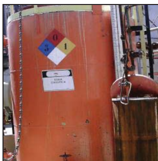
Figura 35: Estanque de Soda al 10% Tratamiento 2 Alquilación
