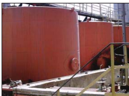
Figura 38: Estanques de Descarga de Ácido Sulfúrico
