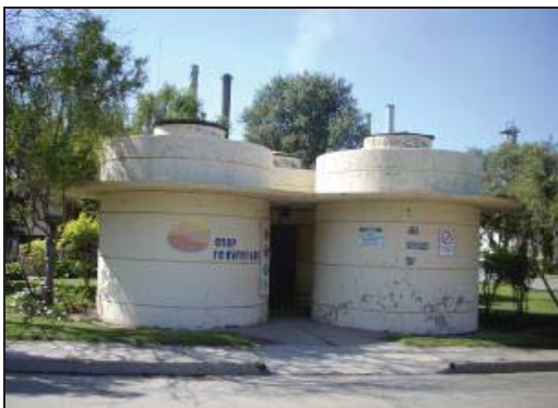
Figura 18: Silo de Gases
