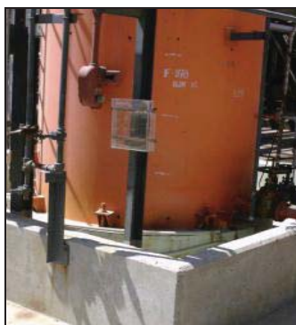
Figura 39: Estanque de Soda al 10%
