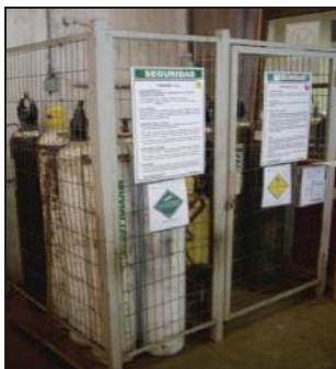
Figura 13: Almacenamiento de Gases Comprimidos
