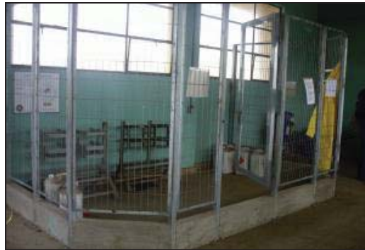
Figura 44: Almacenamiento Sala Caldera
