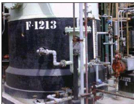
Figura 26: Estanque de Dimetildisulfuro
