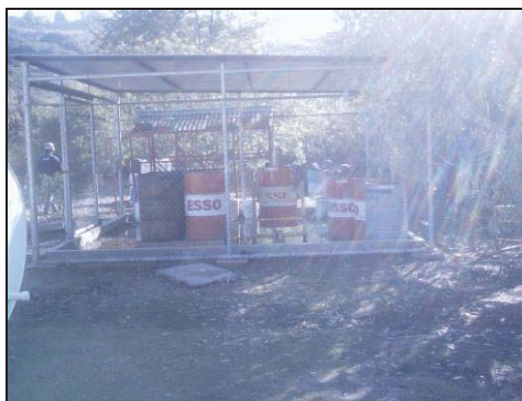
Figura 45: Bodega de Trasvasije de Fracciones de Hidrocarburos
