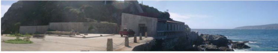
5º EDIFICIO D. Estructura con muros y sin techumbre, de 320 m2. Restaurada por la Fundación Quintay
