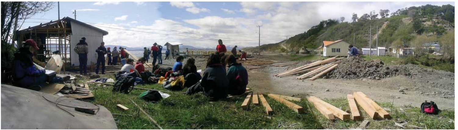
panorámica de la obra / Sede en la desembocadura del Rio Ukika
