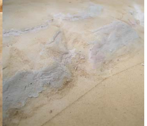
Detalle de enmasillado
