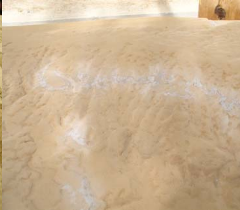
Enmasillado de grietas
