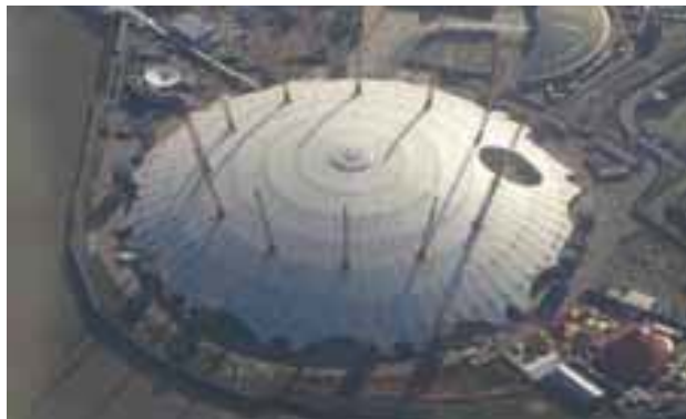
Vista exterior Domo Millenium
