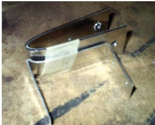
Primero se remacha la pieza de conexión con la pieza que recibe el perfil vertical y luego ambas a la estructura de soporte. El montaje está terminado cuando se inserta un trozo de goma en la pieza que recibe al perfil, esto para asegurar el ajuste y evitar que el perfil vertical se deslice.
