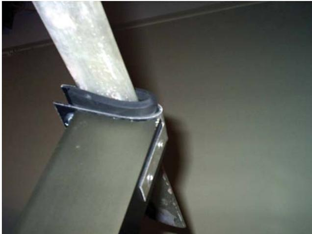
Una vez que se a verificado que los perfiles estén en el lugar correspondiente se pegan con resina mezclada con hilos de fibra de vidrio, esta se introduce dentro del perfil sustentador y por sobre
