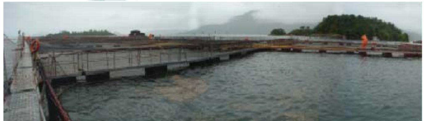
Centro de engorda de las salmoneras, estructura flotante en red con las bodegas, oficinas y casas flotantes construidas en ferrocemento.
