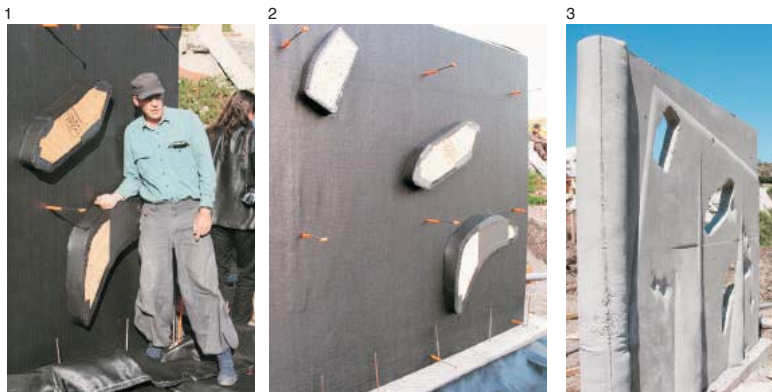
1. MARK WEST Director Centre for Architectural Structures and Technology (CAST). 2. Muro construido en la Ciudad Abierta donde se expone la tecnología constructiva del “hormigón libre” precast freeform . 3. Muro finalizado.
