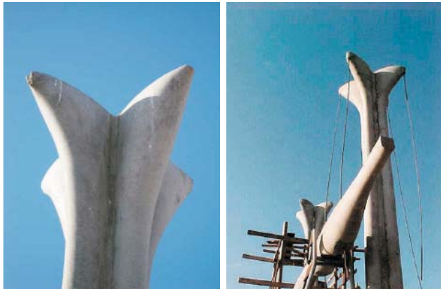
Experimentación con la tecnología de los moldajes flexibles, pilares y vigas realizadas en la Ciudad Abierta.
